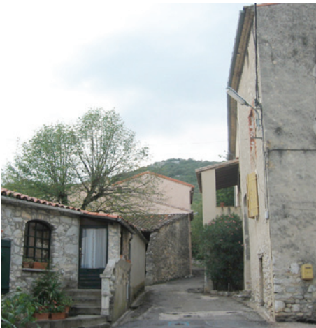
A l'origine du projet, une maison de plain-pied en pierre apparente
