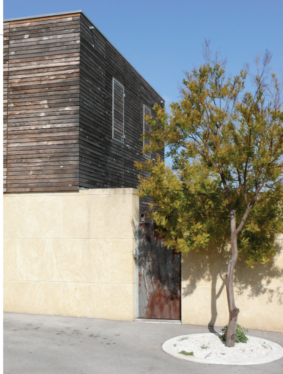
Les «Villas Vanille» - 17 maisons individuelles à patio, à Montpellier - allient ossature bois et bardage bois à la pierre de Vers-Pont-du-Gard, matériaux qui nécessitent peu d'entretien. (Origine du Douglas : scierie de Saint-Pons-de-Thomières).
