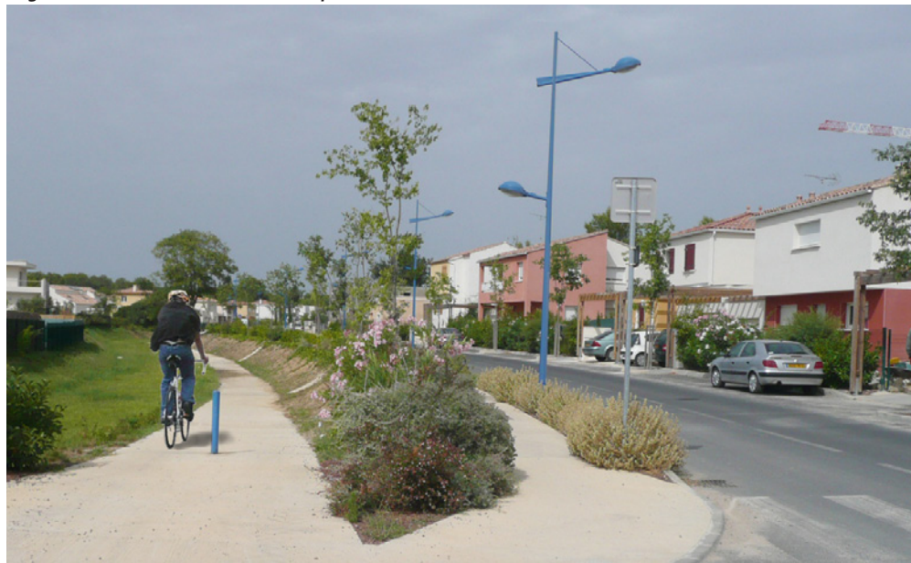
Trottoirs et pistes cyclables bien identifiés, aménagements lisibles, confortables, continus, sécurisés et entretenus dans le temps : de quoi favoriser le développement des déplacements doux. Le Crès (34).
