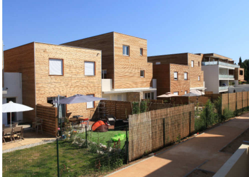
Habitat groupé aux façades rythmées, appartements traversants, terrasses ou jardins privatifs abrités, liaisons piétonnes : cette opération offre une transition douce entre espace urbain et environnement naturel. Régis'street, ZAC des Grisettes, Montpellier. Architectes : C. Moralès et P. Siméon
