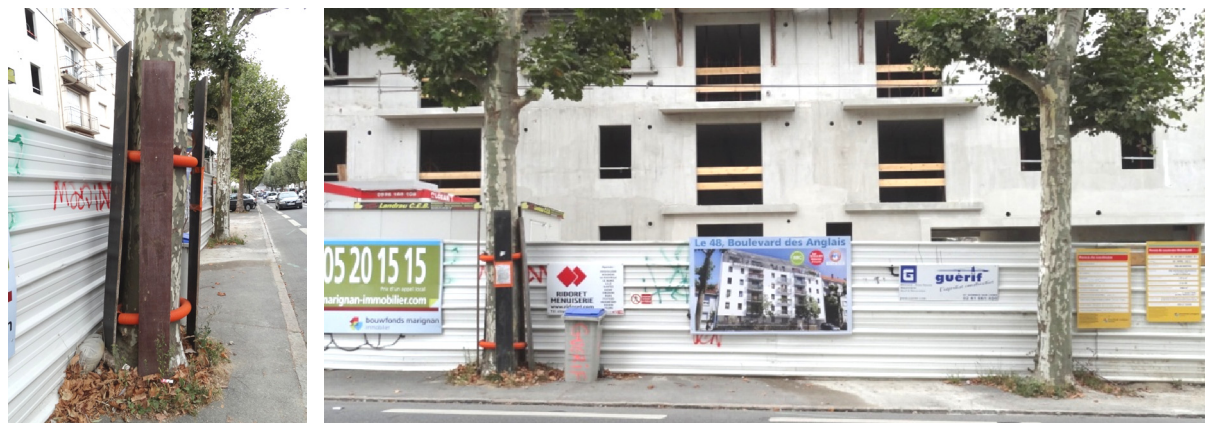
Figure 7 : Protections temporaires de chantier à Nantes (Le Gourriérec, 05/09/2012). Ici deux drains suffisent à maintenir des planches autour de l'arbre, mais tous les arbres de ce chantier n'ont pas reçu ce dispositif, comme le montre le sujet de droite.
