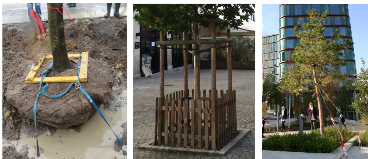
Figure 17 : Trois systèmes pour stabiliser les arbres (Le Gourriérec, 2011). De gauche à droite : ancrage de motte à l'Atoll d'Angers, tuteurage quadripode à Nantes et haubanage d'un conifère à Copenhague au Danemark.
