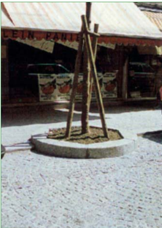
▲ Protection par une bordure haute en granit (Valenciennes)
