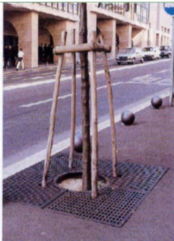
▲ Grille d'acier avec trous pour les tuteurs et bornes de protection (Marseille)
