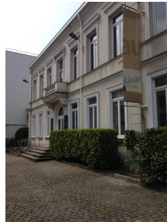
Figure 1 Photographie de la façade du CAUE du Nord Source : Patrick MERLIER
