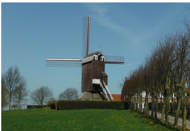
Figure 16 Photographie du moulin de BOESCHEPE Source : Emeline GERBAUT
