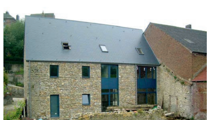
Rénovation avec démolition d'espaces annexés au bâtiment afin de retrouver la cohérence du bâtiment principal. La façade est alors restructurée tout en utilisant de la pierre comme matériau local. © Eric Dubois
