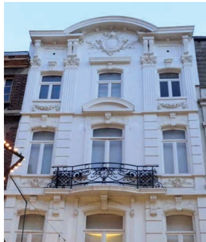
Rénovation de façade avec maintien d'éléments d'origine remis en valeur (ornements, ferronnerie, revêtement).
