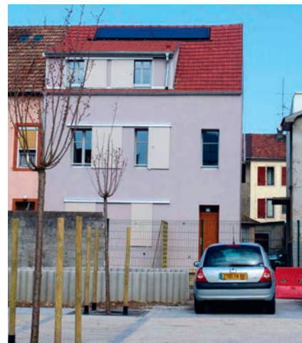
Façade arrière isolée par l'extérieur
