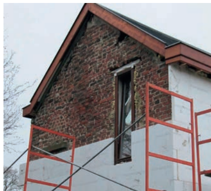
Isolation par l'extérieur avant l'application d'un enduit de façade.
