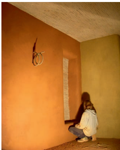
Mise en œuvre d'un enduit à base de terre sur les murs. Le plafond est recouvert d'un canisse de roseau agrafé et enduit de kaolin laissant apparaître le roseau. © Julien Lefrancq (Entreprise Paille-Tech)
