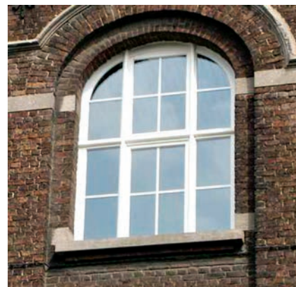
Remplacement des châssis anciens par de nouveaux châssis intégrant du double vitrage et réalisés dans l'esprit des précédents.
