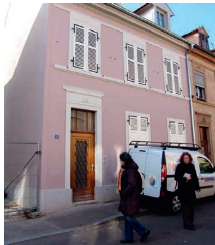
Façade avant isolée par l'intérieur
