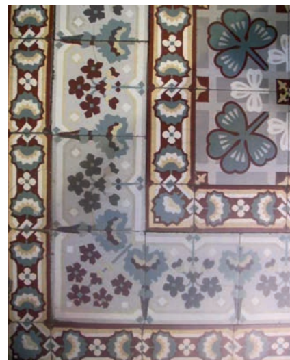
Carreaux de ciment conservés sur le sol d'une maison et isolation par la cave.
