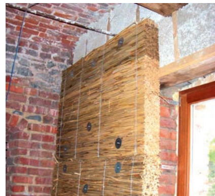
Isolation par l'intérieur à l'aide de panneaux de roseaux.
