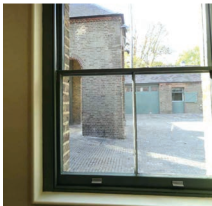
Insertion de double vitrage dans le châssis d'origine.
