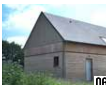
Maison - Le Merzer Jean-Yves Danno 15 kWh/(m 2 .an)
