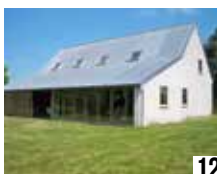
Rénovation - Pordic Christophe Gauffeny 20 kWh/(m 2 .an)
