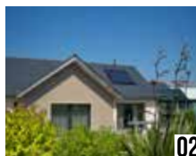
Maison - Fréhel Entreprise Le Tohic 14 kWh/(m 2 .an)
