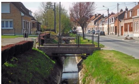
Figure 40: pont permettant de rejoindre la route
