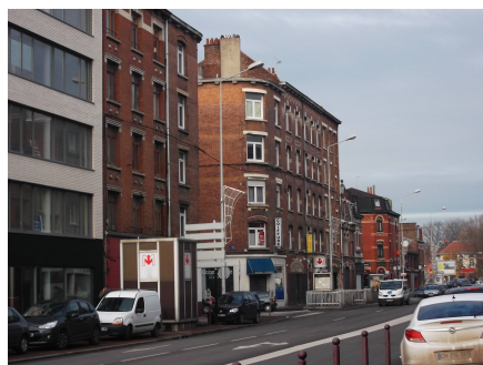
Entrée de la station de métro Bois-Blancs
