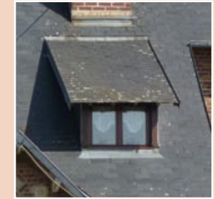
Lucarne rampante dite «chien couché».
