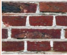
«à la française»: superpose un lit de largeur et un lit de longueur de brique.
