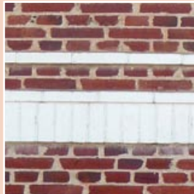
Brique industrielle. Sa forme est régulière et sa couleur est rouge foncé, bichromie obtenue par des briques de couleur blanche.
