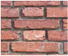
Appareillage. Mise en œuvre de la brique. «à l'anglaise»: croise une largeur et une longueur sur un même lit de brique.
