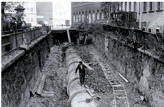
Fig. 114 Réalisation de la conduite de l'Elster en 1965
