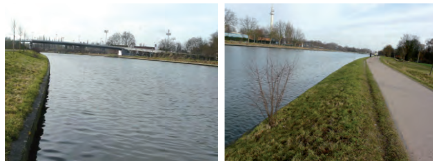
Fig. 86 Berges potentiellement aménageables (la Deûle au quartier des Bois-Blancs)
