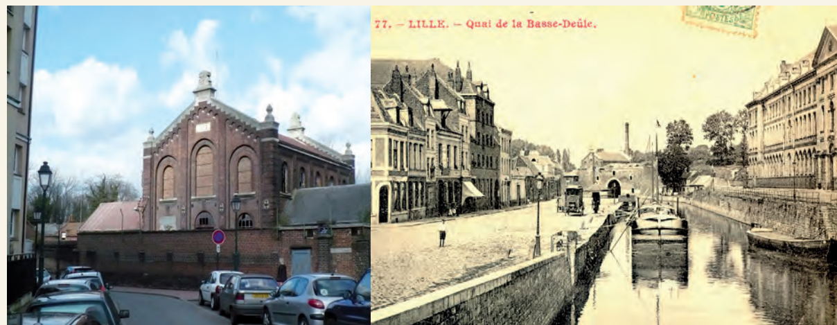
Fig. 39 L'usine élévatrice aujourd'hui et hier, au fond de l'image du quai de la Basse-Deûle
