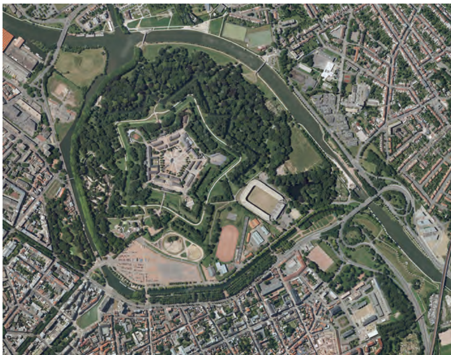
Fig. 27 Vue aérienne de la Citadelle (avant démolition du stade)
