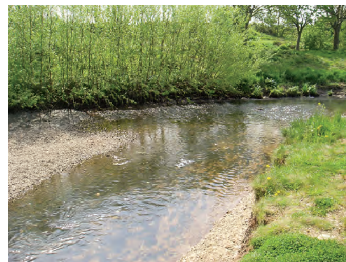
Fig. 123 La rivière Brent confinée dans une goulotte en béton, selon le modèle appliqué sur l'ensemble des ruisseaux du Grand Londres; pendant les travaux en 2003, et trois ans après l'achèvement des travaux; la berge est constituée par du béton concassé (caché) fixé par un rideau de saules vivants, constituant un habitat favorable à la biodiversité. THE RIVER RESTORATION CENTRE
