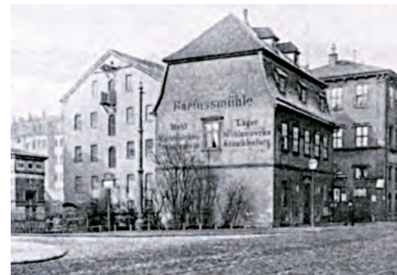
Fig. 111 Exemple de bâtiment industriel implanté sur un ancien bras de la rivière en centre ville.
