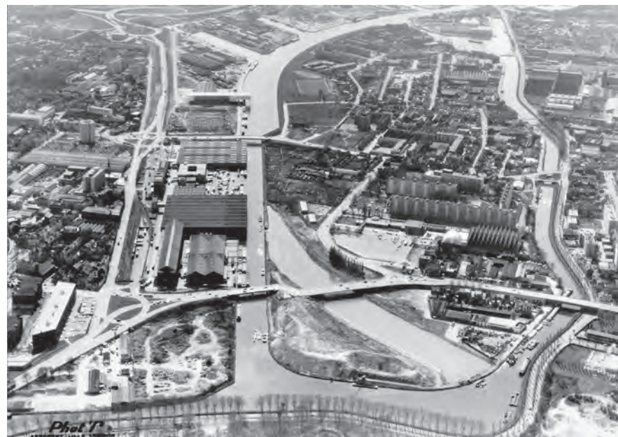
Fig. 21 Construction du canal à grand gabarit en 1977 SOURCE ATLAS HISTORIQUE
