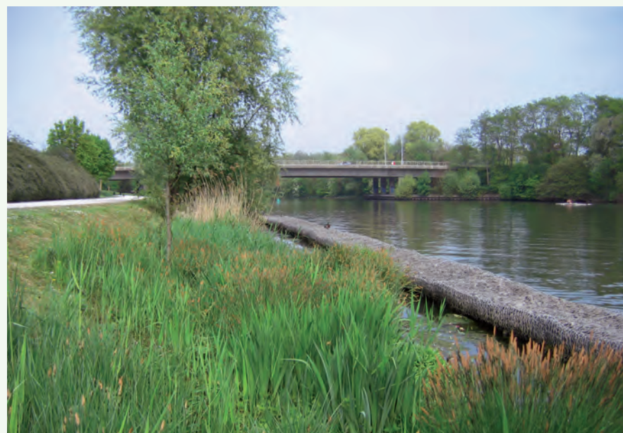
Fig. 95 Berge en pente douce protégée par des gabions, sur l'île des Bois Blancs PHOTO YOHAN TISON
