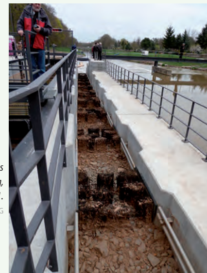
Fig. 144 Ouvrage mixte passe à poissons et glissière à canoës sur l'Elster à Leipzig, attendant à l'écluse ouverte en 2011.
