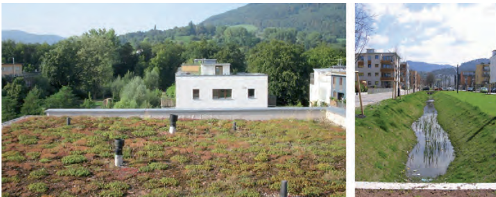
Fig. 72 Toitures végétalisées à Fribourg-en-Brisgau.
