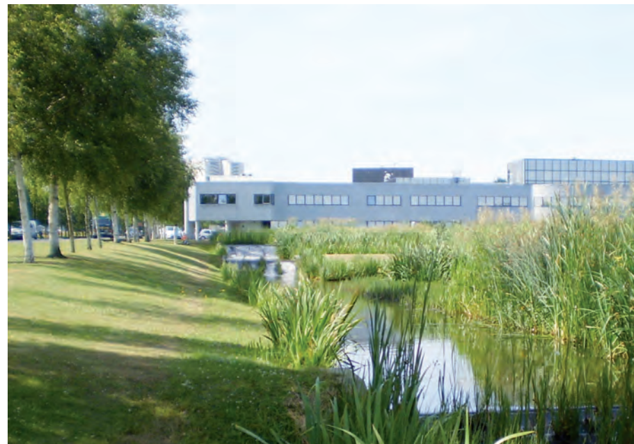
Fig. 69 Canalisation et filtrage naturel des eaux de ruissellement sur le campus de Caen
