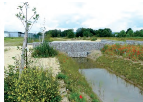
Fig. 75 Évocation des fonctions traditionnelles de la voie d'eau à Saint-Etienne-de-Rouvray : phytoremédiation et mise en scène au Parc du Clos Allard
