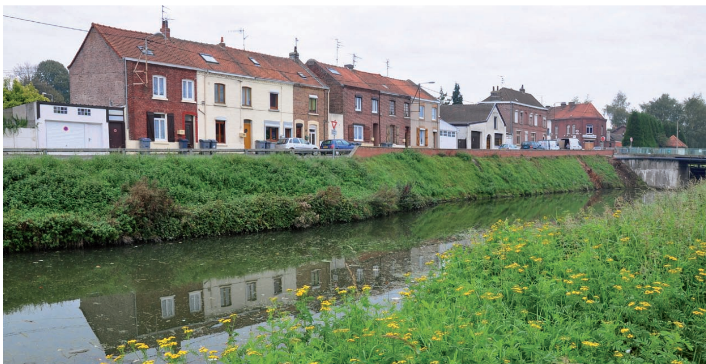
Alignements de pavillons le long du canal à Don . Faute d'entretien, les berges se dégradent et nécessiteraient des travaux.
