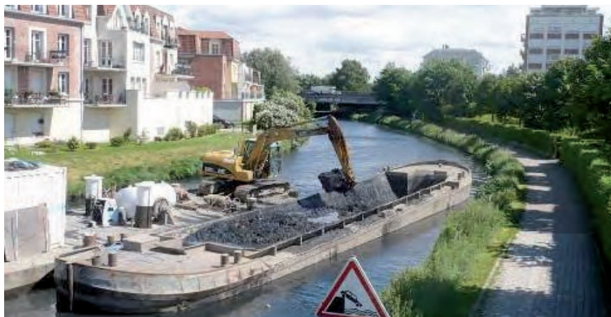
Marcq-en-Baroeuil. Opérations de dragage en vue de la remise en navigation
