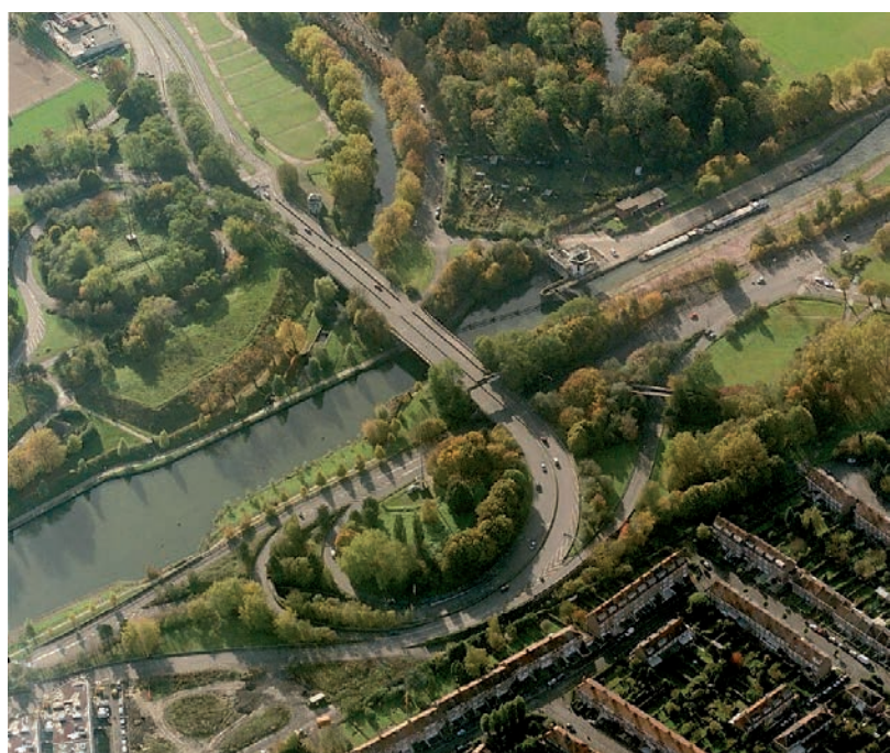
L'échangeur du Pont Royal sur les communes de Lille, Saint-André et Lambersart. Une réflexion commune sur l'intégration de l'ouvrage et son réaménagement paysager est souhaitée par certains acteurs comme la commune de Lambersart.
