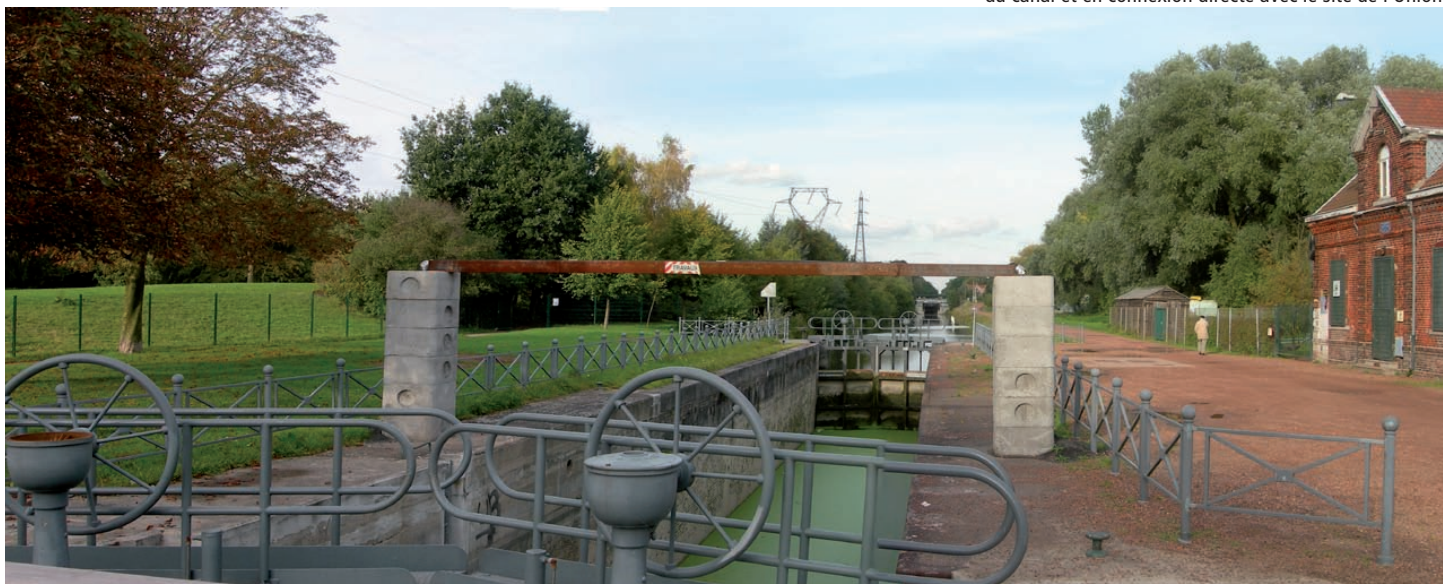
Ecluse réhabilitée dans le cadre du projet Blue Links (Wasquehal)
