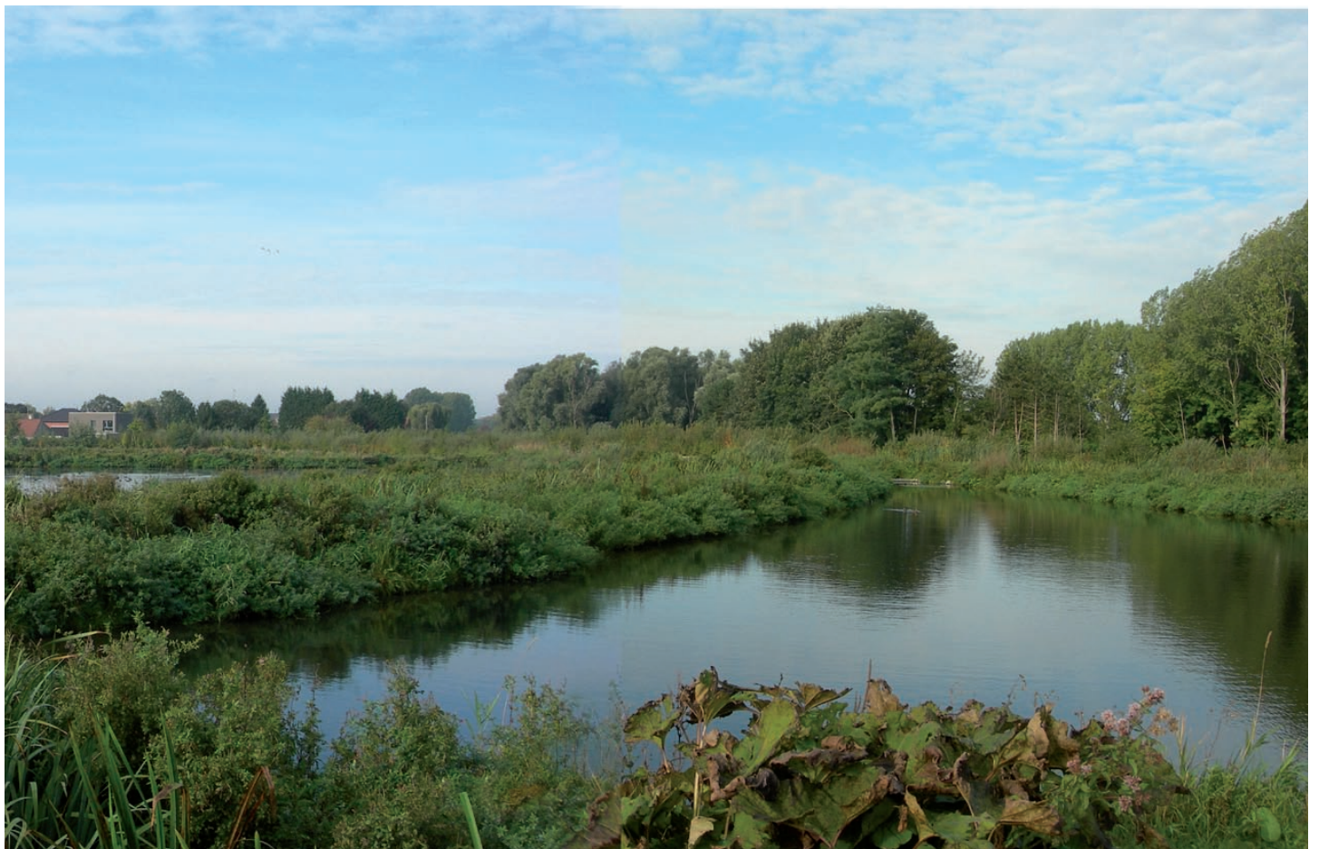
Grimonpont - les bassins filtrants
