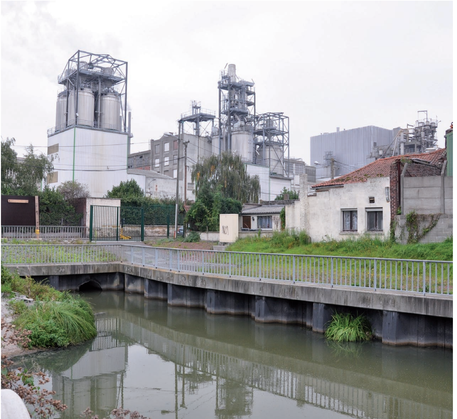
Traitement des berges à Haubourdin
