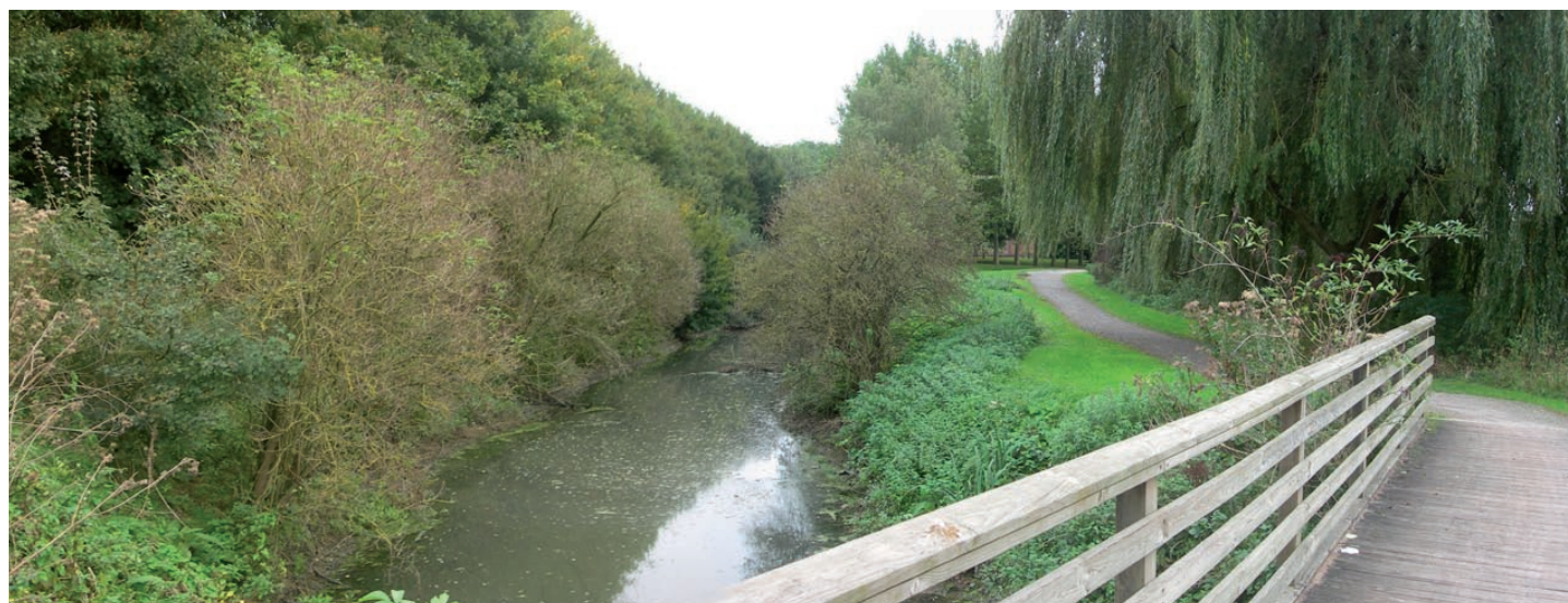
Passerelle sur le l'étang de la Justice au droit de l'écluse de Quesnoy-sur-Deûle
