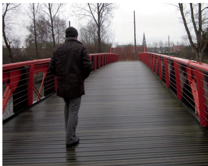
Ci contre et ci-dessus : passerelles vers l'île de Balokken
