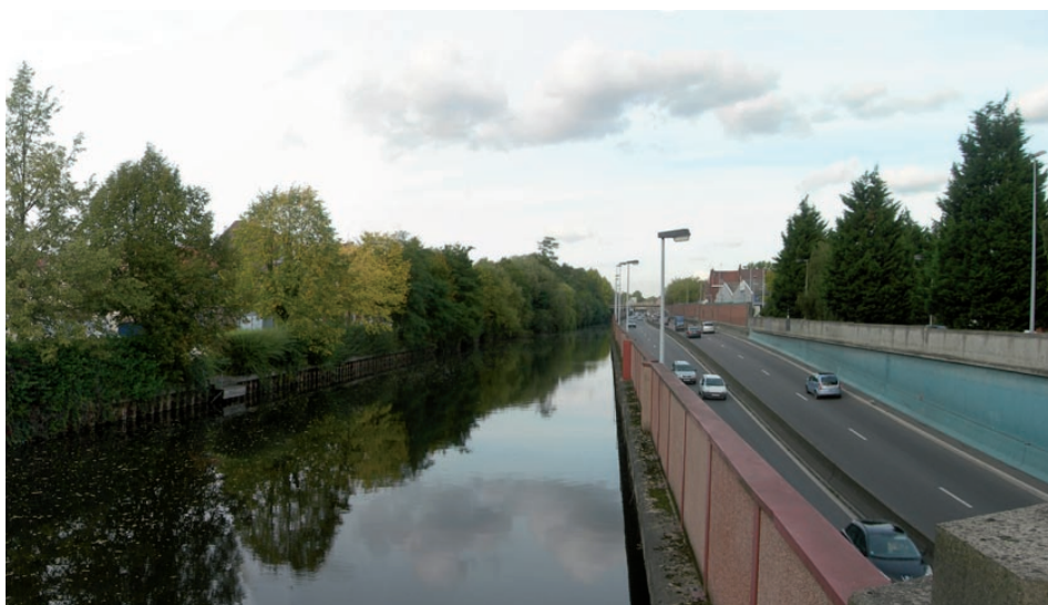
Rive du canal confisquée par la route départementale à Tourcoing
