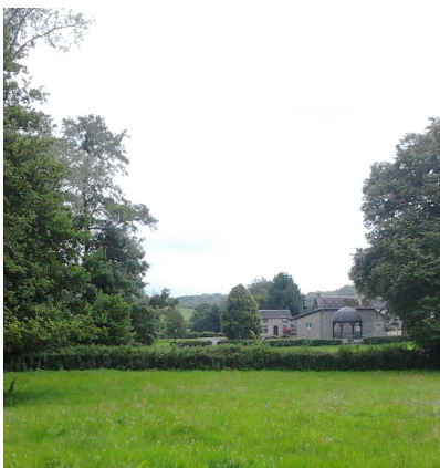
Co-visibilités depuis la parcelle, Hestrud ©CAUE du Nord
