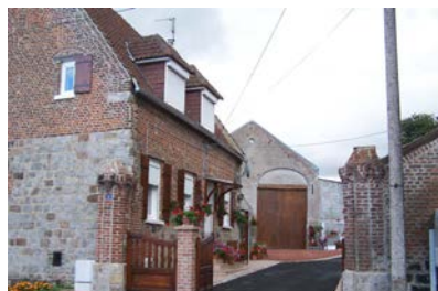
Ferme à pignon sur rue de St Quentin
