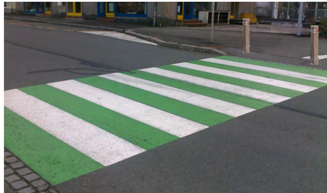
Signalisation au sol des traversées (résine colorée gravillonnée) Bornes en bois rétro réfléchissantes au droit des passages.
