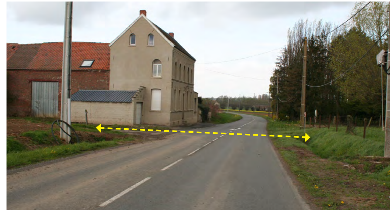
Route de Denain - Sécurisation des traversée piétonnes ou cyclistes
