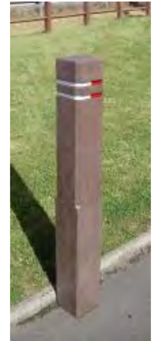
Signalisation au sol des traversées (résine colorée gravillonnée) Bornes en bois rétro réfléchissantes au droit des passages.
