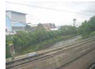
Site industriel et voie ferrée entre Haumont et Maubeuge
