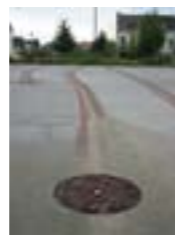
Fontainerie et recueil de l'eau de ruissellement, Place de l'Industrie, Sous-le-Bois
