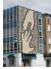
Sur la façade à l'angle de Rue de la Croix
