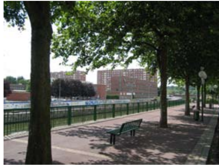
Depuis le mail de Sambre, vue sur la rive opposée qui fût entièrement remblayée avant la reconstruction, et au fond, le Pont Rouge qui assure la continuité du Boulevard de l'Europe.
