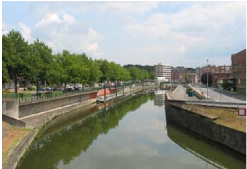
Fond de vallée de la Sambre entre le mail et le quai des Nerviens à l'amont de l'écluse
