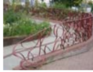
Rampe contemporaine, place de l'industrie Sous-le-Bois
