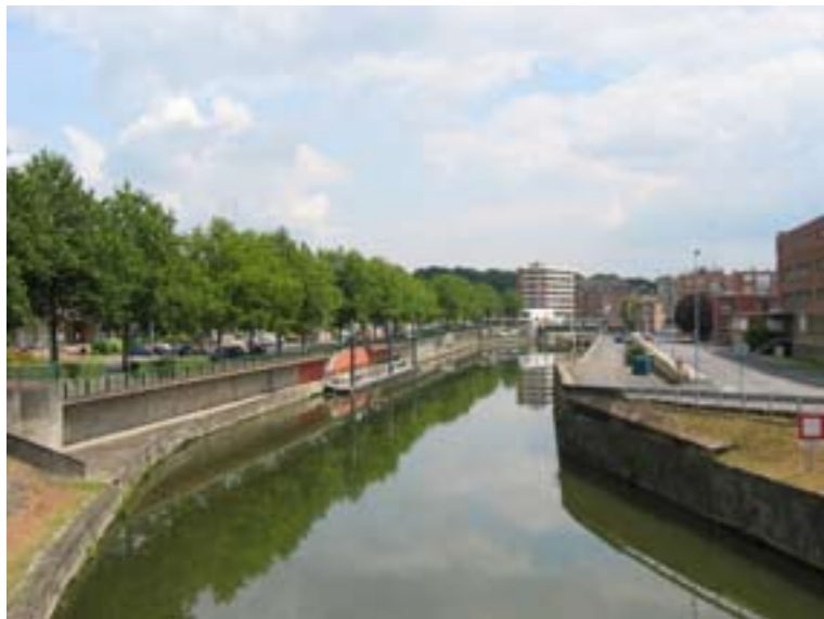
La Sambre canalisée dans sa traversée du centre-ville. A gauche, le mail de la Sambre et son alignement de Platanes, à droite, le Quai des Nerviens
