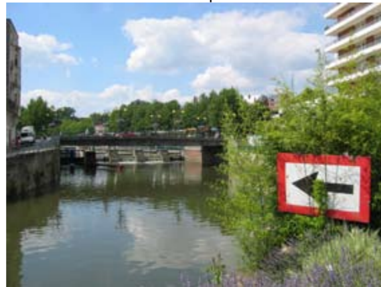
Le pont de Sambre relie l'Avenue Jean Mabuse (rive gauche) à L'Avenue de France (rive droite)
