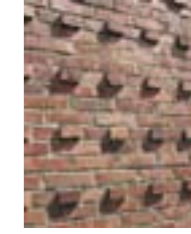
Travail de la brique Immeuble Lecluyse, Place de la Concorde
