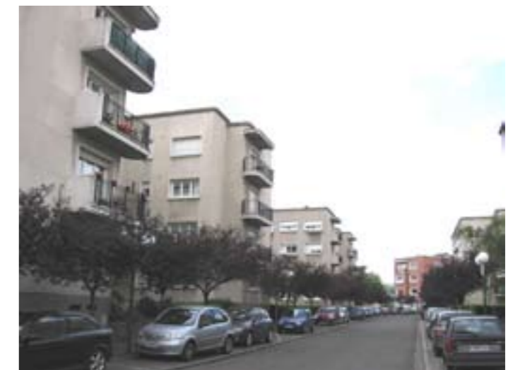
La Rue des Arts et ses Immeubles de l'urbanisme de Lurçat avec ses toits en terrasse et ses alignements d'arbres
