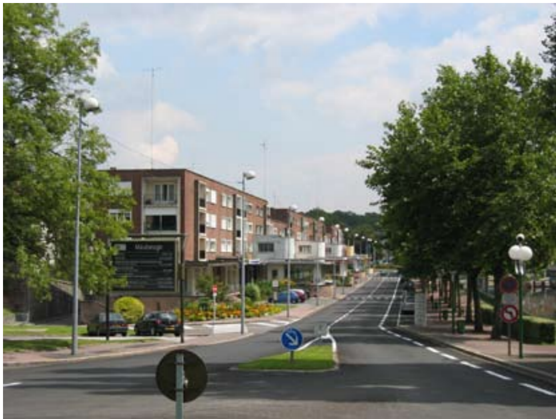
Les constructions avec les toit en terrasse associant habitat et commerce bordant le Mail de la Sambre
