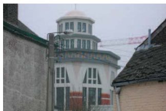
Rotonde de l'Hôpital avec motif décoratif en béton armé et décor de brique
