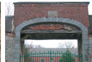
Porche de ferme avec arc en pierre bleue en anse de panier
