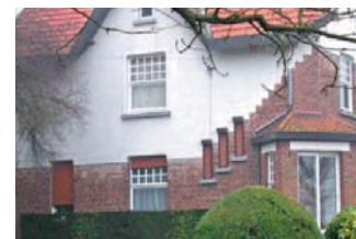
Maçonnerie de brique et enduit décoratif
