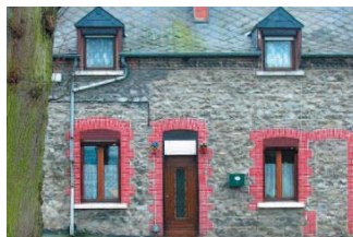
Maçonnerie de pierre avec corniche et encadrement de baie en briques
