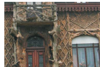
Maçonnerie de rocaille en béton
