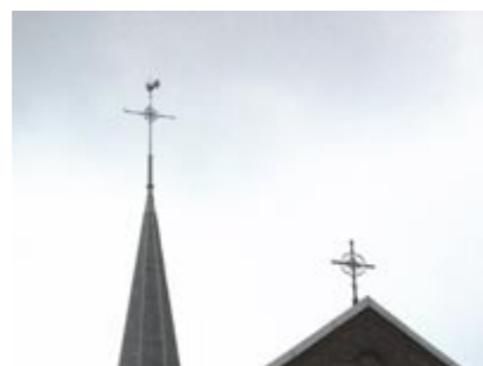
Girouette du clocher de l'église et croix au sommet du toit
