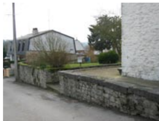
Maçonnerie de soutènement pour régler les différences de niveau liées à la pente
