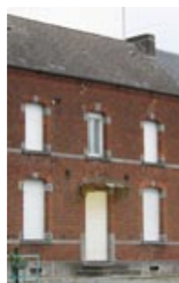
Baie à arc surbaissé avec encadrement avec alternance de brique et pierre. Corniche denticulée. Niveau souligné par un cordon de pierre
