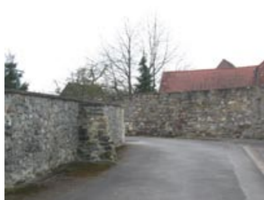
Murs en moellons de pierre
