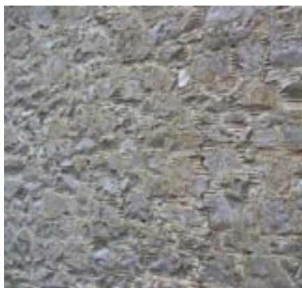
Moellons de pierre bleue avec effet de rainure dans les joints épais et irréguliers
