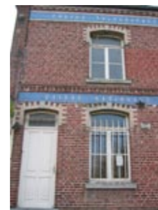
Ornements de façade en faïence et brique de couleur
