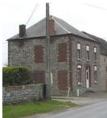
Encadrement des baies et chaînage d'angle en brique. Moellons en pierre bleue
