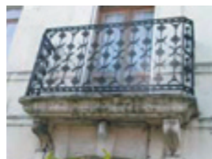
Garde-corps en ferronnerie
