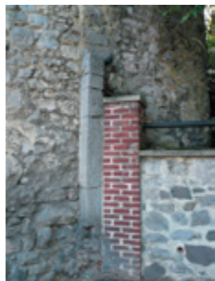
Murs en moellons de pierre
