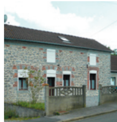
Encadrement des baies et chaînage d'angle en brique. Moellons en pierre bleue
