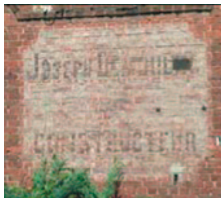
Travail publicitaire sur le pignon de l'ancienne gare
