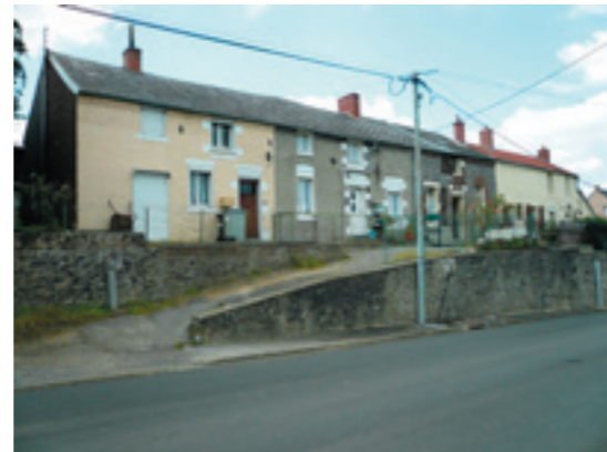
Maçonnerie de soutènement pour régler les différences de niveau liées à la pente
