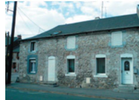
Maison rurale transformée en logement social
