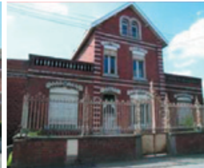
Maison bourgeoise en brique, terre cuite émaillée et grille en fer forgé
