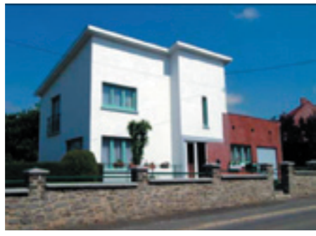
Habitations en structure béton avec extension
