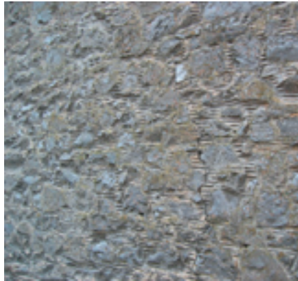
Moellons de pierre bleue avec effet de rainure dans les joints épais et irréguliers
