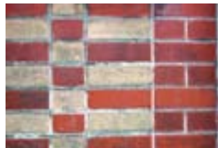
Appareillage de briques jaunes et rouges
