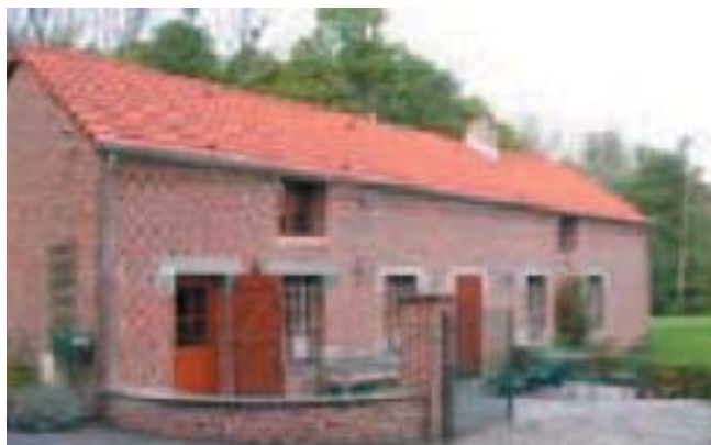
ferme élémentaire restaurée et reconvertie
