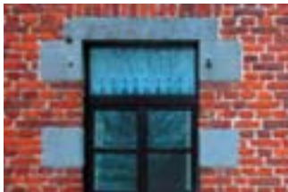
linteau pierre bleue en insertion dans murmur briques et sous bassement en moellons de briques
