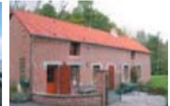
ancienne ferme élémentaire réhabilitée
