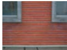
Façade mairie ciment et mur plaquettes briques
