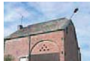
Arc en plein cintre maçonné et percé de ventilations
