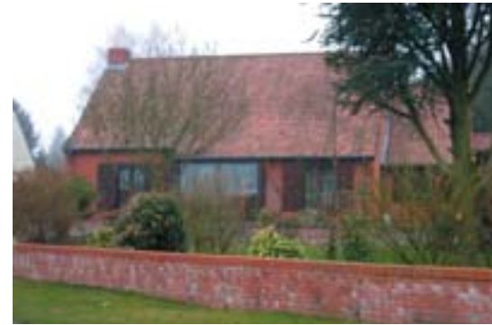
Pavillon récent le long de la rue Keyworth
