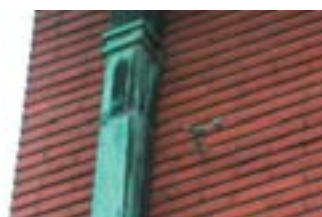
Gouttière en cuivre
