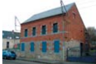
maison de bourg réhaussée
