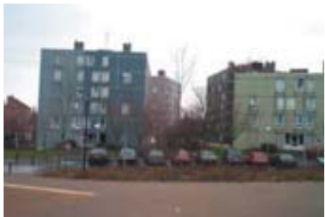
Cité des Explorateurs - logements collectifs des années 70
