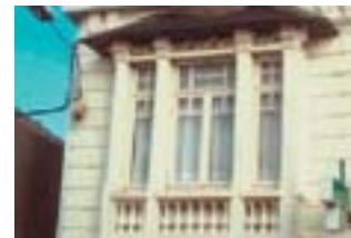
Baie à meneaux maçonnes et ouvragés
