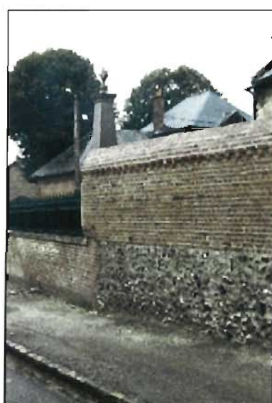
Le silex est principalement utilisé en sous-bassement ou en remplissage de murs. Boussières en Cbis . (MAT 001)
