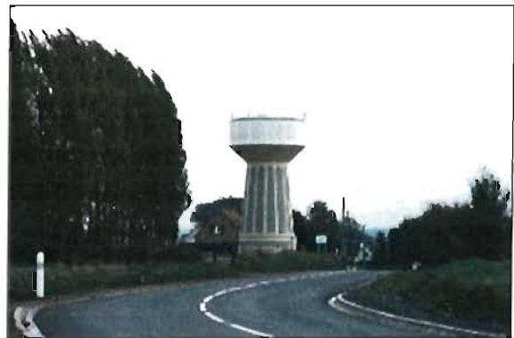
La ressource en eau est toujours une problématique majeure du territoire. Cette ressource s'affiche aujourd'hui à travers les nombreux châteaux d'eau : château d'eau d'Awoingt . (CH 001)
