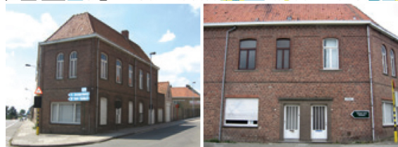
< Nieuwkerke: articulerend gebouw op de hoek van de Seulestraat en de Heirweg.
