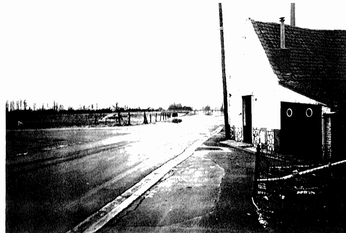
49 Passage souterrain pour piétons
