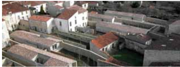
Babled, Nouvel et Reynaud architectes pour SEMIS - ZAC de l'Arc de Triomphe, Saintes (17)
