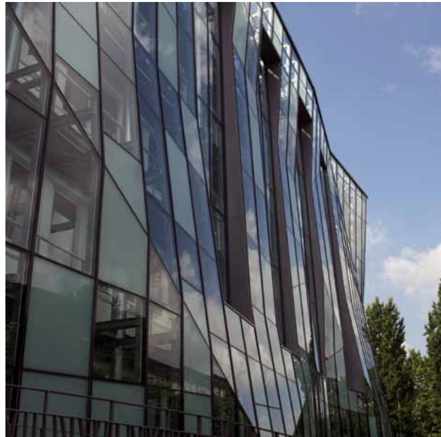
Charlety, Rambourdin, Rivoire, architectes - Façade double-peau, Immeuble La Montagne, Clermont-Ferrand (63)
