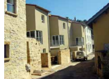
MTA Architectes - St-Maurice-ès-Allier (63)
