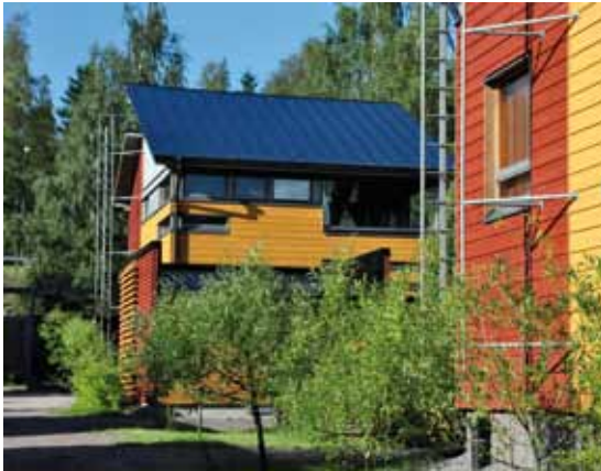
Chauffage solaire, Helsinki - Finlande
