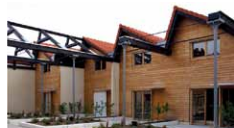
Axis Architecture, L. Thomassin - Réhabilitation du bâti industriel en logements - OPAC 43 Le Puy-en-Velay (43)
