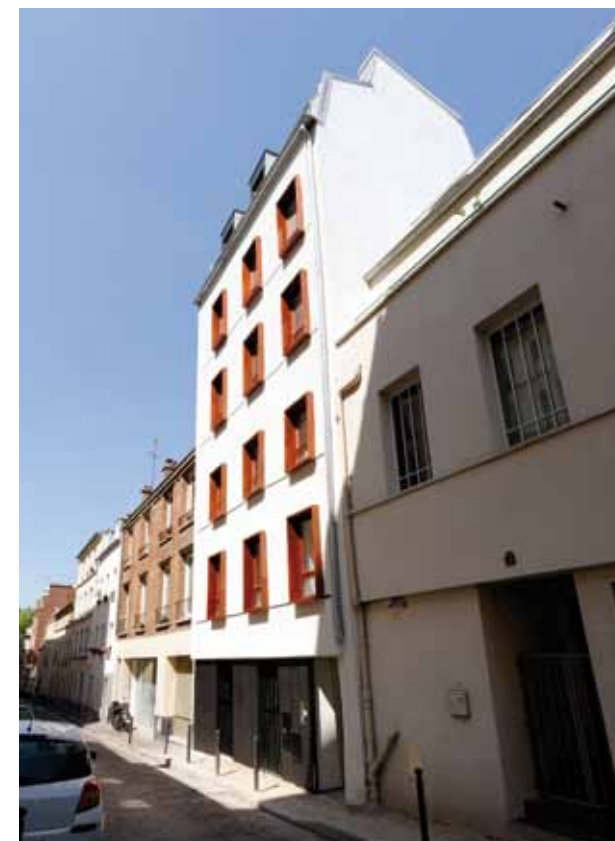
Marti Architectes - Réhabilitation avec isolation par l'extérieur, Paris (75)
