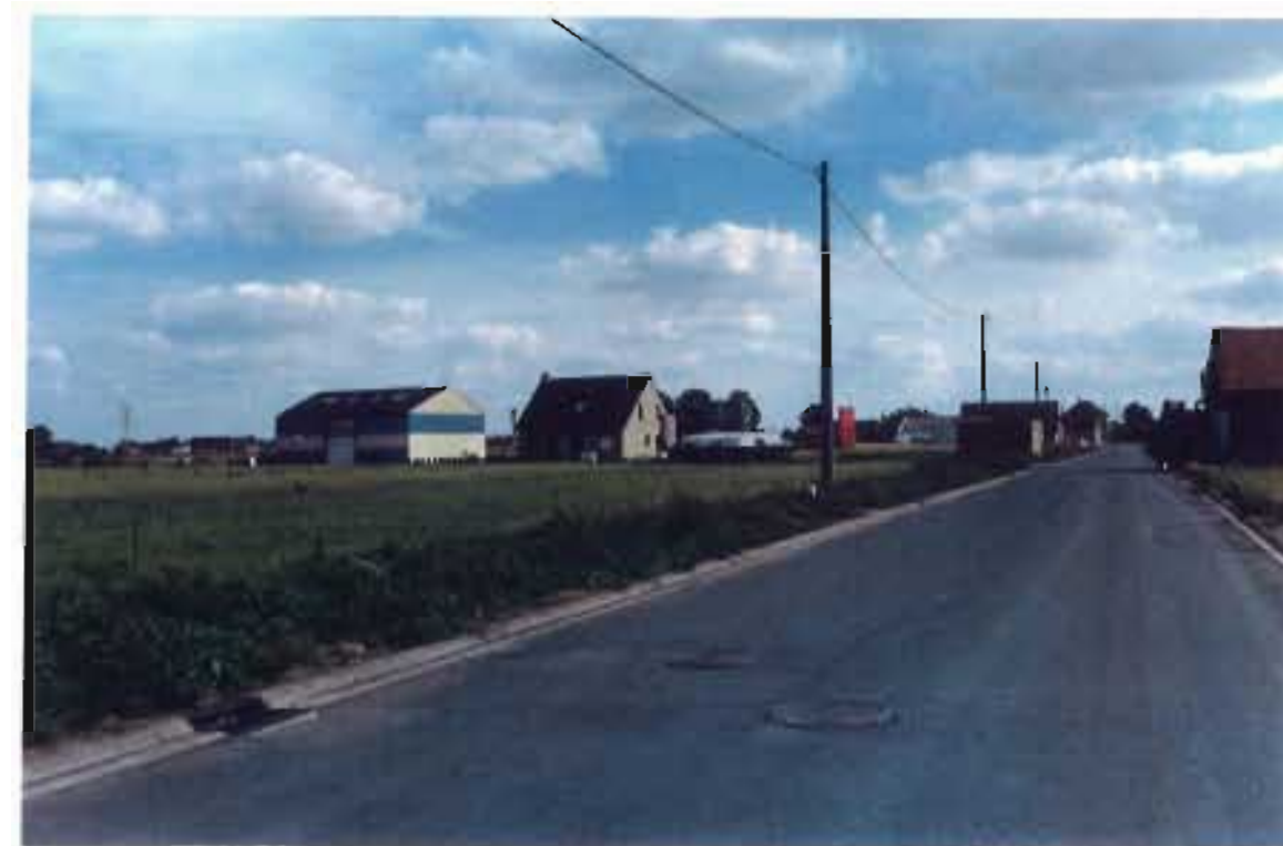
L'aménagement de la voirie consiste en une simple mise en place d'un ruban d'enrobé
