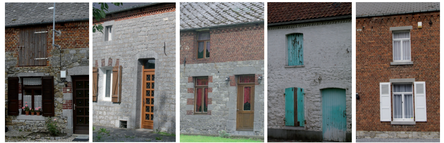
Surélévation en brique sur un rez-de-chaussée en maçonnerie composite.
