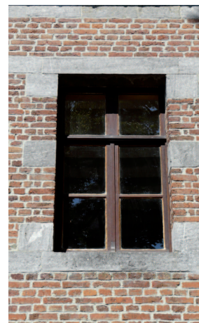
Linteau droit prolongé par des bandeaux en calcaire, milieu du XIX e siècle.
