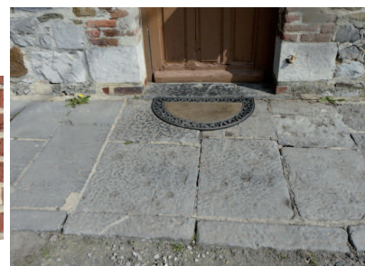
Trottoir en dalle de calcaire.
