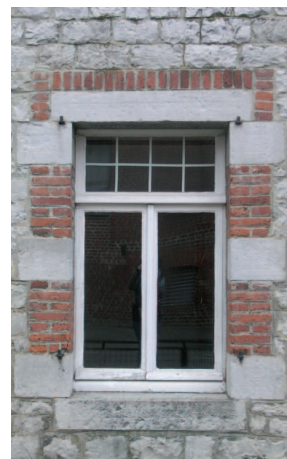
Linteau droit surmonté d'un rang de brique, première moitié du XIX e siècle.
