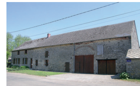
Ferme élémentaire à Hestrud.
