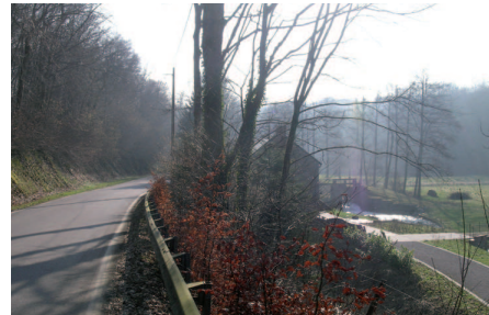
Vannes et bâtiment restauré, lieu-dit La scierie de forêt.
