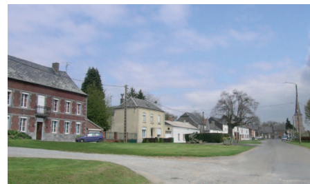
Front bâti unilatéral sur la Place à Obrechies.
