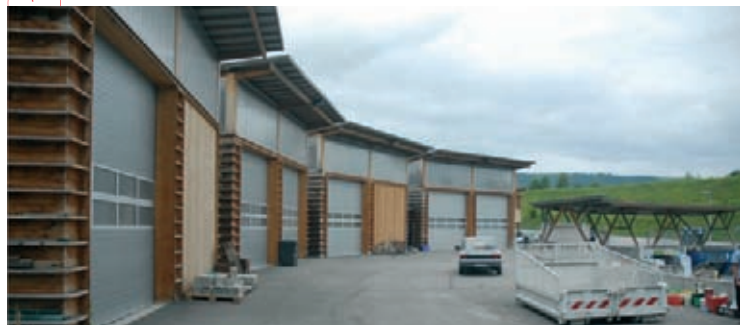
Photographies 1 à 7 (p. 15 et 16), centre technique de Metz-Tessy, architecte : Agence A3, 2002-2003
