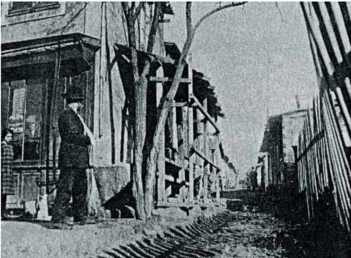
Lotissement défectueux vers 1930
