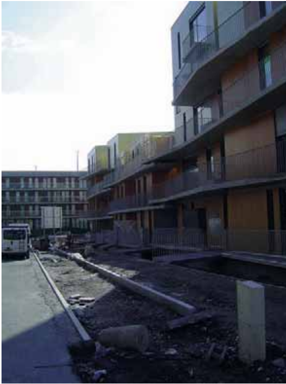
Ci-contre et ci-dessous: Le «bois habité» en chantier
