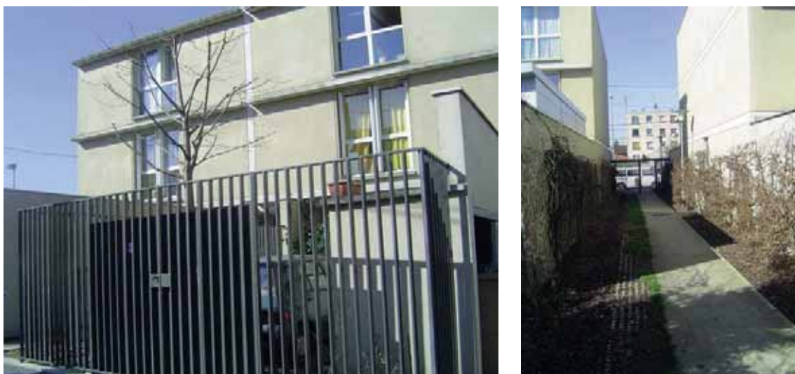
Une végétation qui a des difficultés à se développer
