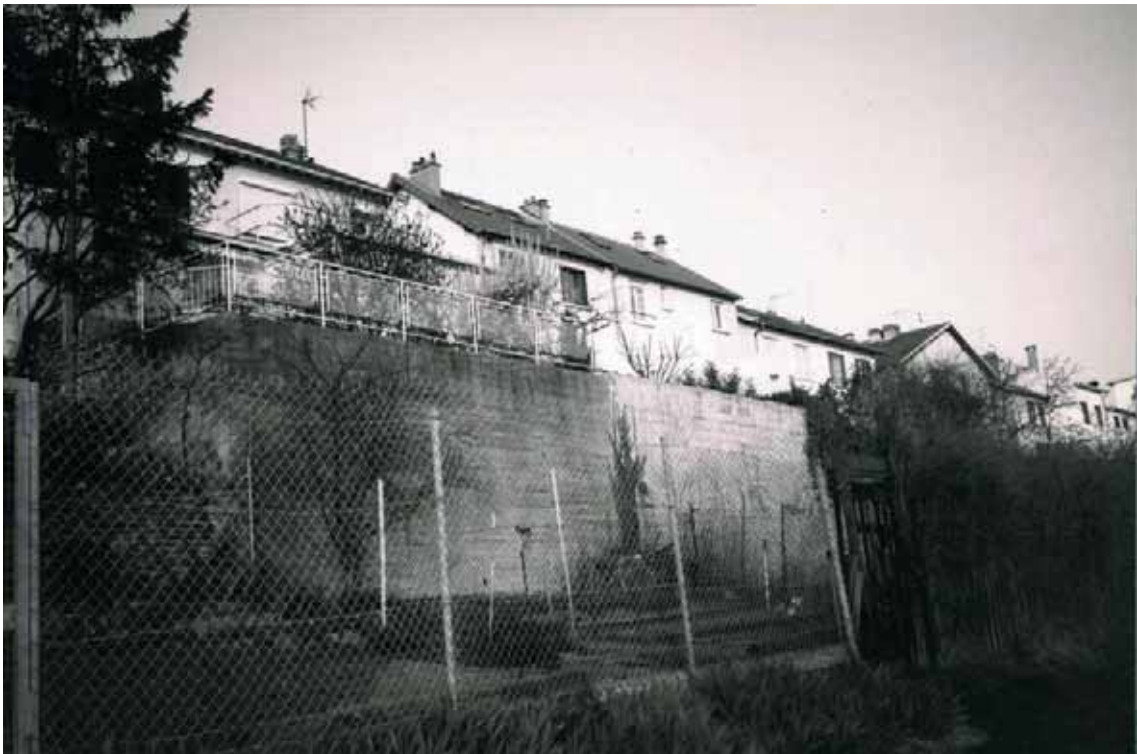
Epinay /Seine, pavillon surplombant le chemin de halage le long de la Seine
