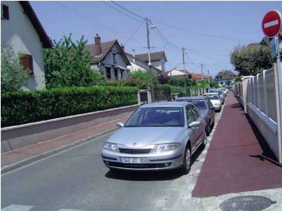
Une rue de lotissement à Pavillons sous bois
