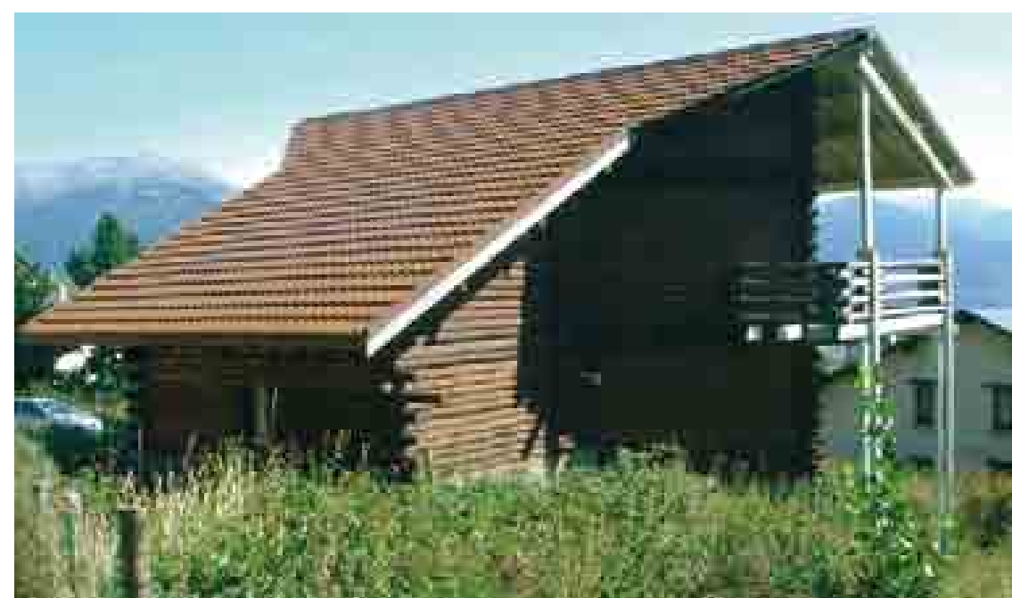
Au nord, la toiture à deux pentes dissymétriques, venant presque «chercher» le sol, protège les parois verticales des intempéries et des regards du voisinage amont.
