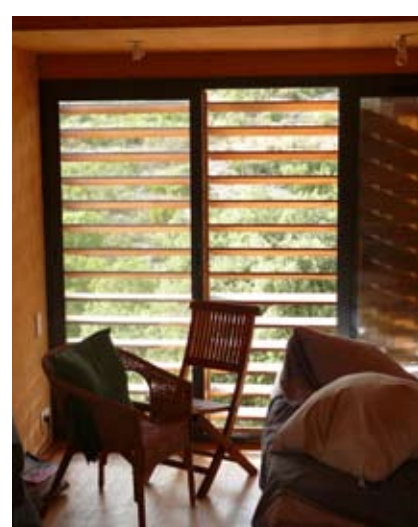
Les persiennes filtrent la lumière, tout en permettant la ventilation.
