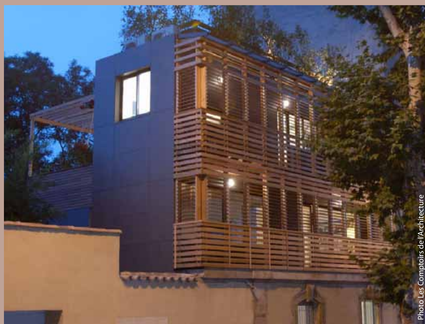
Côté rue, la partie persiennée en bois permet de filtrer la lumière du sud, atténuer les bruits du boulevard et assurer l'intimité.
