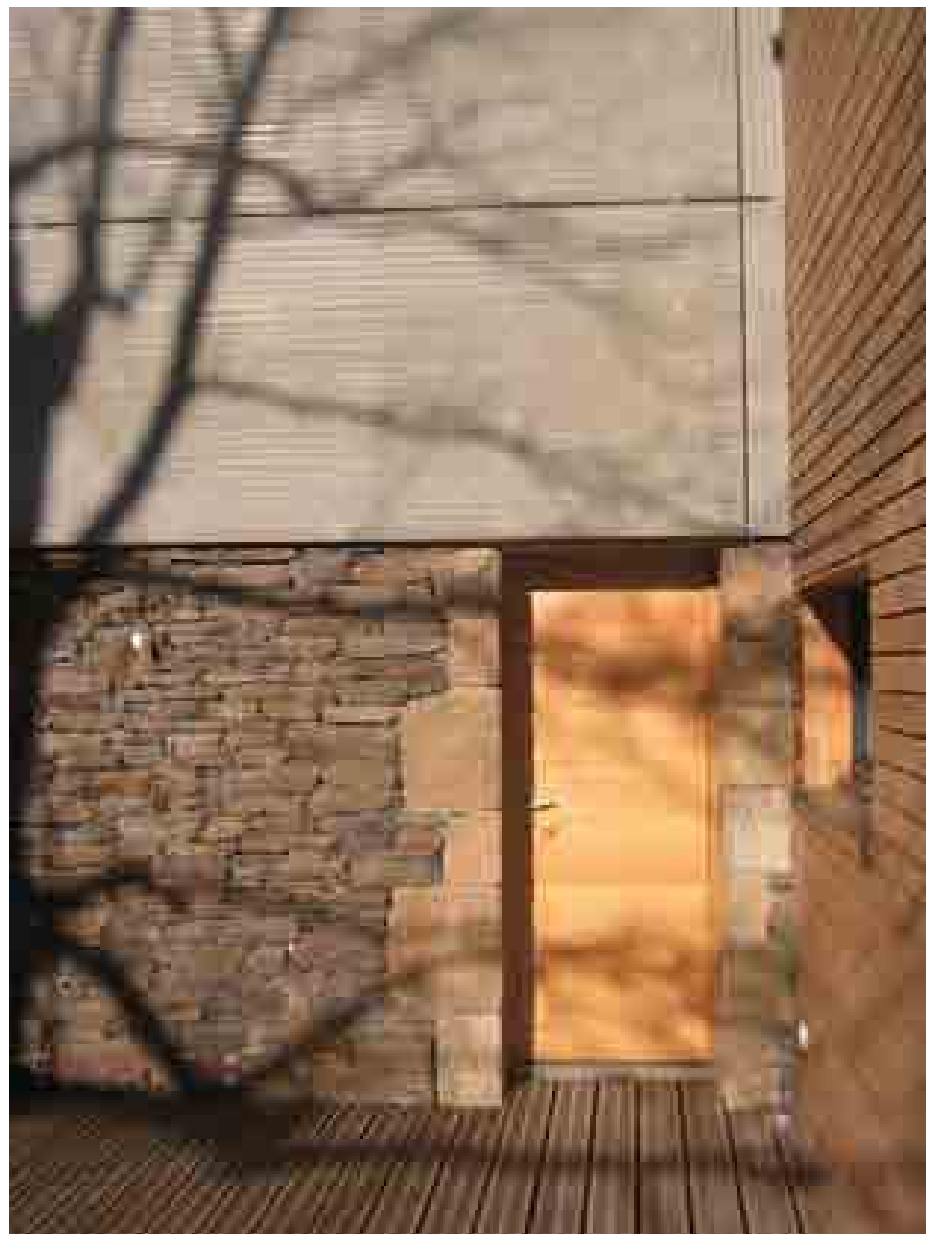
Bardage réalisé en clin de douglas naturel posés à joints ouverts
