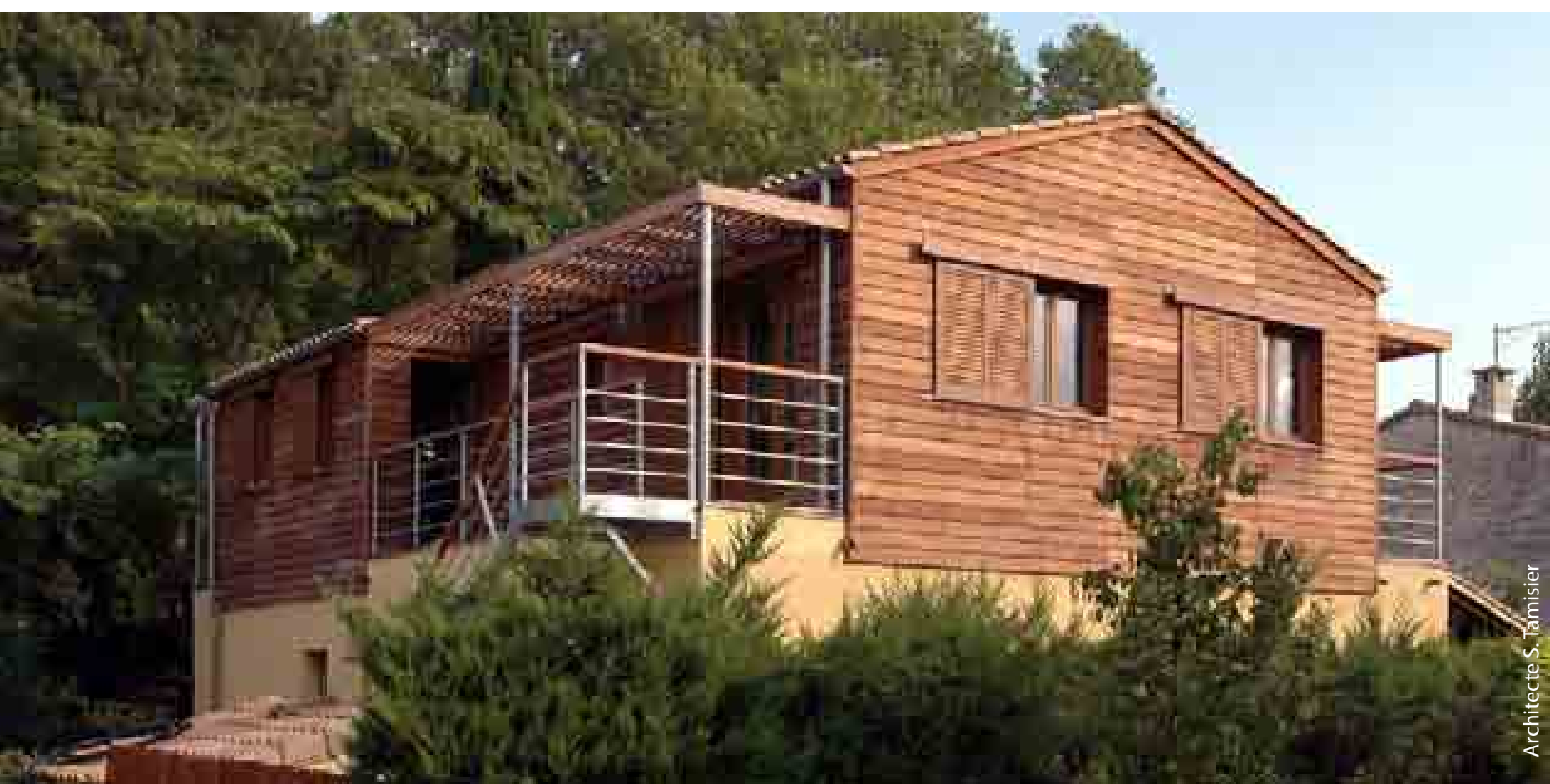
Côté jardin : la surélévation de la toiture a permis de créer un étage. La coursive extérieure dessert, de manière indépendante, une chambre et un studio.
