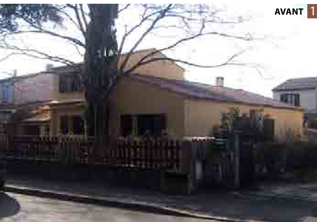
Côté rue, l'existant : une maison jumelée sur une parcelle de 400 m 2 , construite en maçonnerie et recouverte d'un toit en tuile, porté par une charpente traditionnelle.
