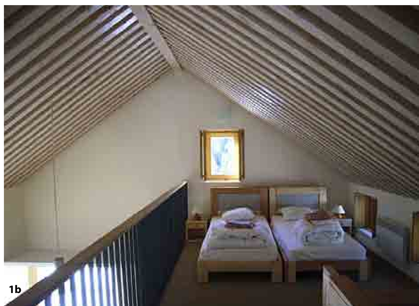
1 - Bâtiment d'accueil - 1a - Charpente à poinçon et entrait - Les arbalétriers sont remplacés par un pan de bois constitué d'un ensemble de solives bois de petites sections, posées tous les 30 cm. 1b - Gîtes - La charpente est réalisée avec une série de solives bois de petites sections, s'appuyant sur une panne faîtière. 2 - Les fermes sont constituées de fines sections carrées 12 x 12 cm, avec poinçon et entrait retroussé, disposées tous les 1,20 m. 3 - Les préaux : la forte présence du bois est «allégée» par la finesse des profils et le tissage du bois et de lumière.
