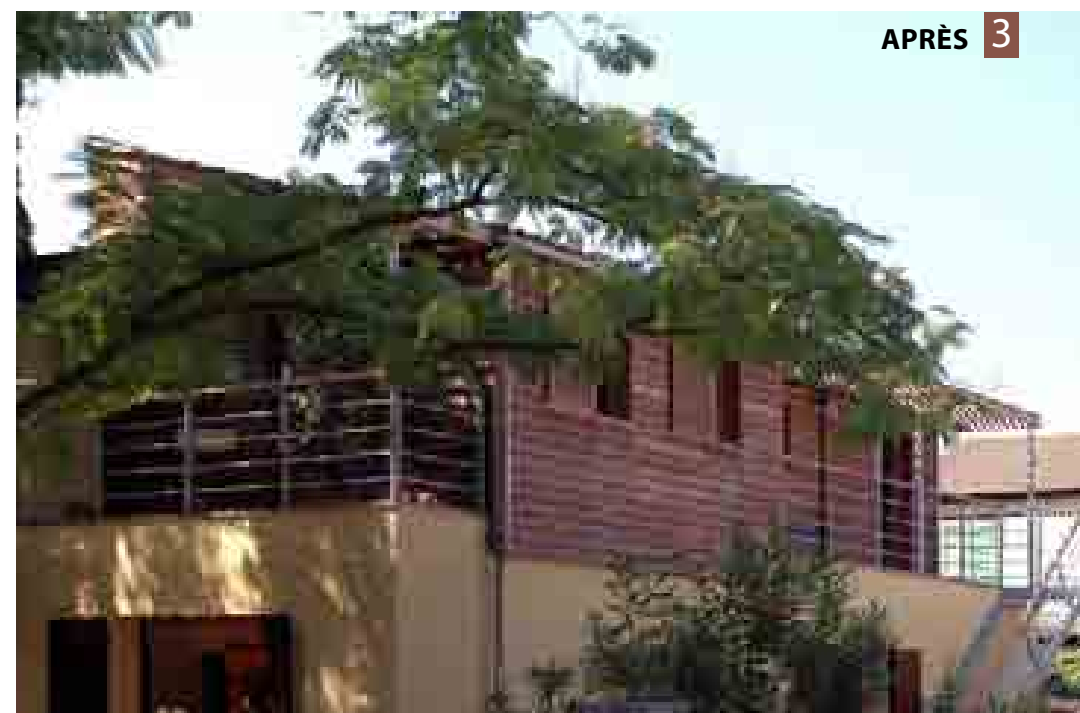
Rapidement, le chantier est hors d'eau et hors d'air. De plus, l'emploi du bois comme procédé de construction limite l'apport d'humidité à la partie habitation existante.
