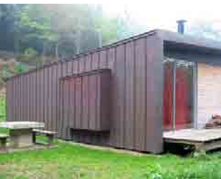
Les bardages sont réalisés en planche de pin Douglas sur les façades Est, Sud et Ouest. Le zinc recouvre et protège le côté Nord.
