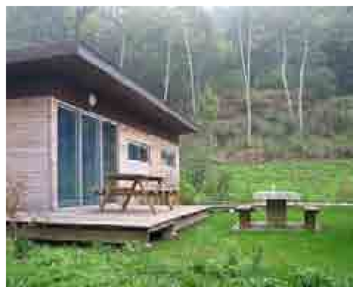
Les bardages sont réalisés en planche de pin Douglas sur les façades Est, Sud et Ouest. Le zinc recouvre et protège le côté Nord.
