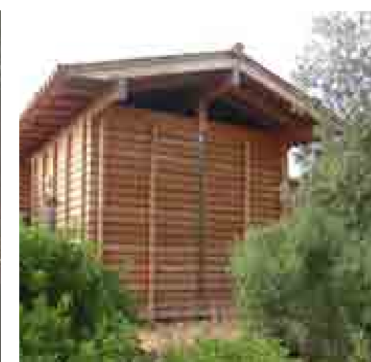
Le bardage bois est réalisé en planches de Douglas sans aucun traitement.
