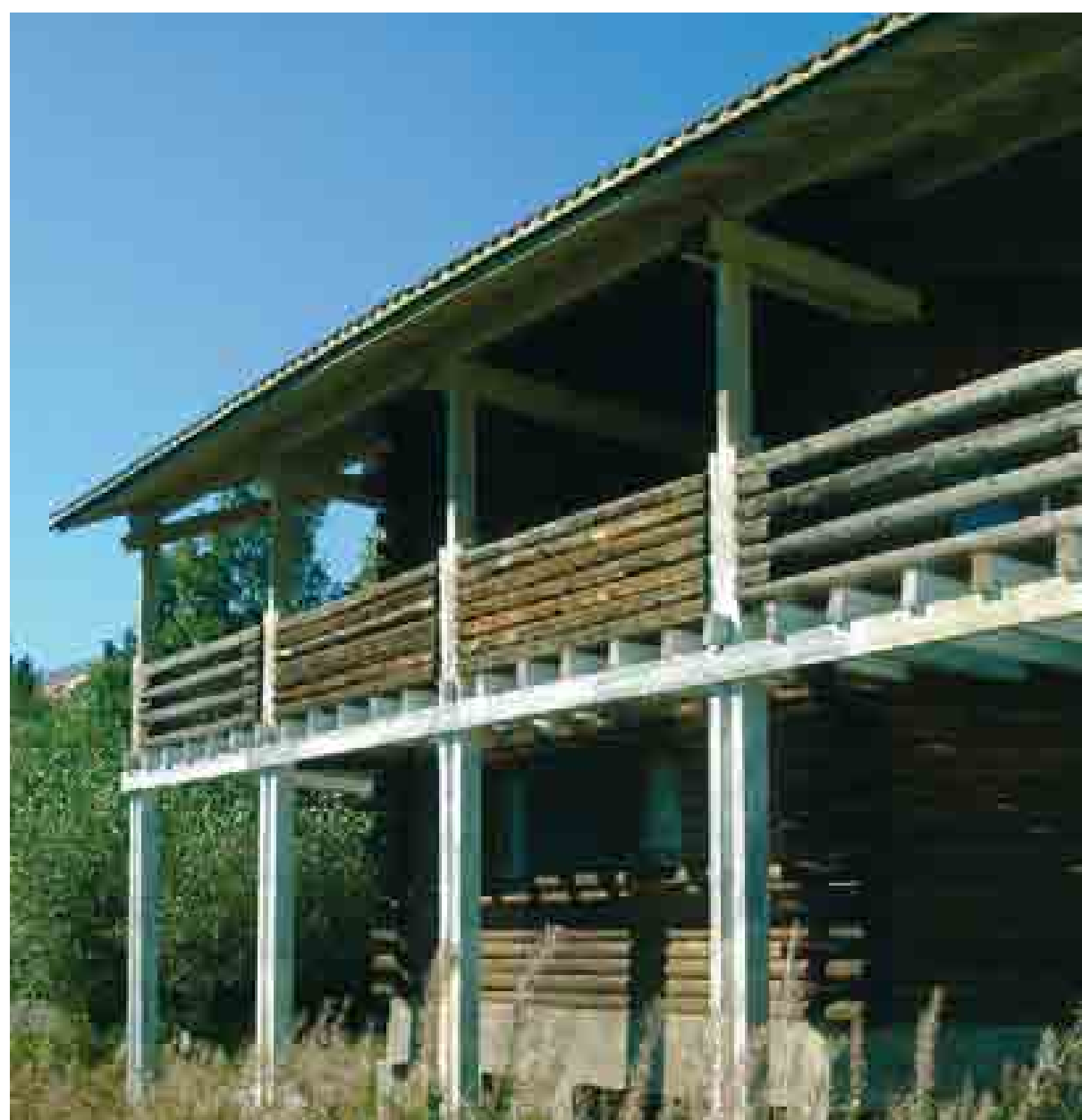
Plus courte au sud, la toiture abrite un spacieux balcon à vivre, ouvert sur le paysage, et protège la façade du soleil en été.
