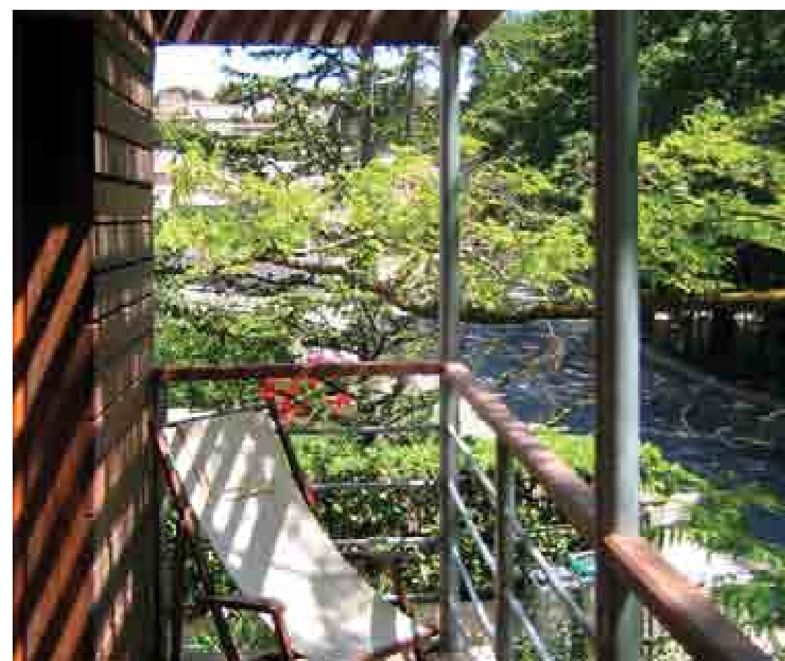
Chaque pièce a sa terrasse extérieure, protégée par une petite pergola en bois, permettant ainsi de réduire l'impact du soleil d'été sur les parties vitrées.
