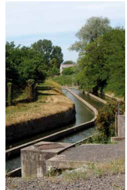
Joze (63) - Canalisation sur le Bédât.
