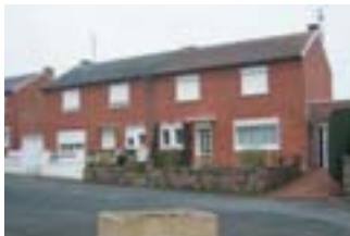
Maisons jumelées dans un lotissement sur le plateau
