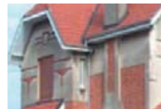
Maçonnerie de briques et enduit ciment décoratif
