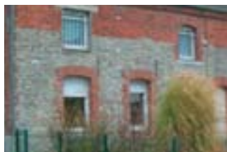
Mur de façade en pierre bleue réhaussé de brique et encadrement des baies
