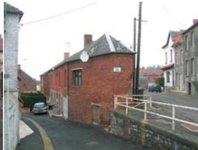
Un réseau de voie très irrégulier dans lequel le bâti rural s'adapte à la pente
