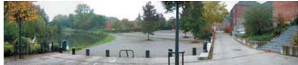
La halte fluviale et la place aménagée en gradins utilisant très judicieusement le cadre «naturel» de la Sambre. Le kiosque domine l'ensemble et assure la relation et le retournement vers la RD959
