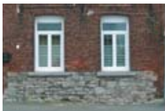
Soubassement en pierre bleue
