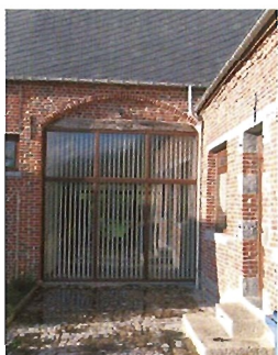
Porte de grange transformée en baie vitrée.
