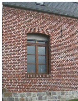
Menuiserie restaurée et volets roulants intégrés.
