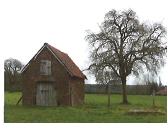
Bâtiment servant à sécher le houblon en lisière de la forêt de Mormal.
