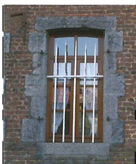
Linteau cintré en calcaire marbrier et barreaudage.
