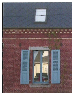
Châssis de toit encastré composé avec la baie existante.
