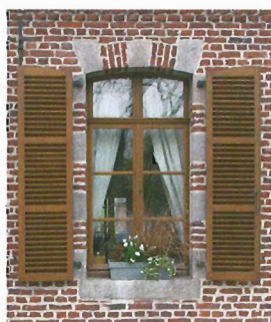
Alternance de briques et de dés de calcaire marbrier.
