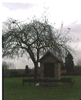
Puits restauré dans une pâture.
