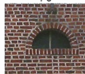
Ouvertures des écuries.
