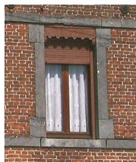
Encadrement en calcaire marbrier avec dés aux angles.
