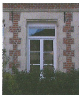
Encadrement en pierre calcaire.
