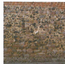
Le mur composite, le silex.
