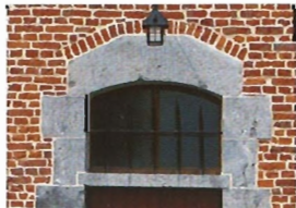
Barreaudage et imposte vitré, linteau cintré en pierre bleue surmonté d'un rang de brique.
