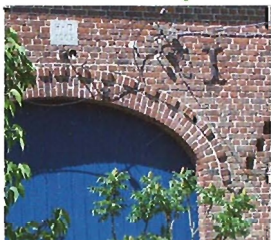
Corniche à modillons sur l'ouverture d'une grange.
