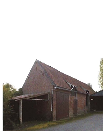
Bâtiment servant au stockage des cagettes et des fruits à Gommegnies.
