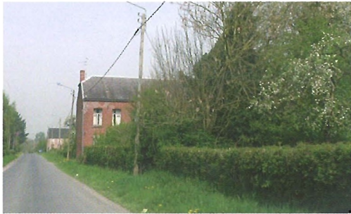
Succession de fermes à pignon sur rue à Villereau.
