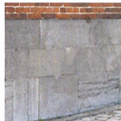
Pierre de taille en calcaire marbrier dit pierre bleue.
