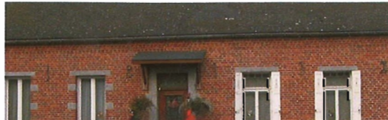
Fers d'ancrage sur le logis.
