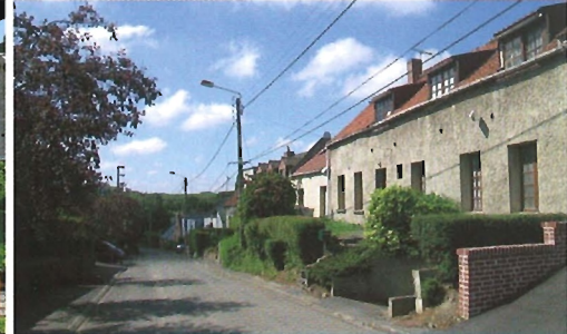
Emmarchements, talus et jardinet le long de la Montée Wibaille à Villers-Pol.
