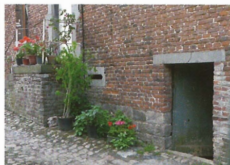
Soupirail et accès au sous-sol à Sepmeries.
