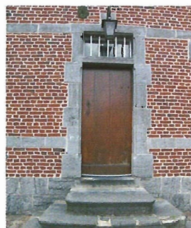
Porte et bandeaux en calcaire marbrier.
