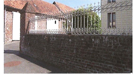
Muret et grille à Villers-Pol.
