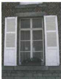
Fenêtre de logis
