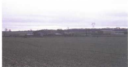
La Malmaison et la Souffrance, à Saint-Rémy-Chaussée, forment une volumétrie bâtie horizontale dans ce paysage ouvert
