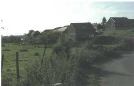
Bâti concentré à Fontaine, situé à mi-hauteur de versant
