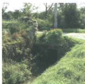
Ponceau permettant l'accès à la ferme située en retrait
