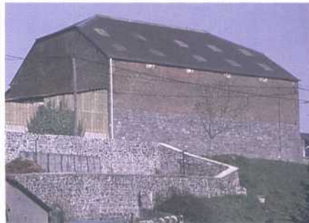
À Fontaine, le relief est maîtrisé à l'aide de murs de soutènement
