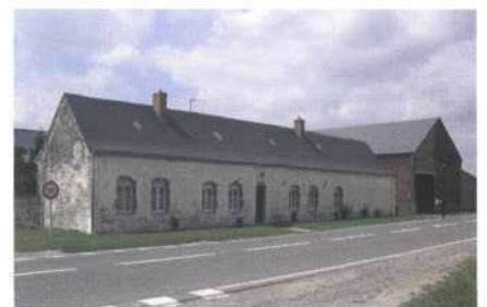
La ferme est un point de repère important en bordure de la RN2
