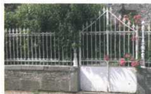
Mur-bahut en pierres surmonté d'une grille
