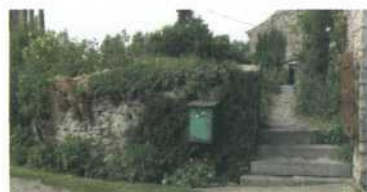
Mur de soutènement.
