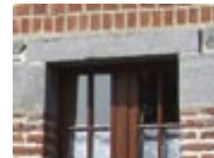
Linteau en pierre bleue
