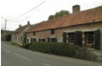
Maisons élémentaires formant l'alignement bâti du hameau.
