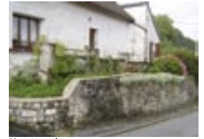
Muret en pierre.
