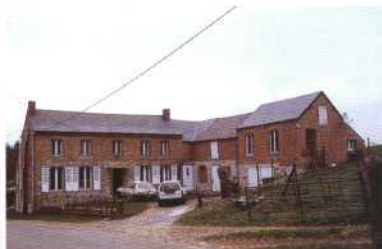
ferme à Saint-Hilaire-sur-Helpe
