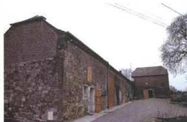
ferme à Saint-Hilaire-sur-Helpe
