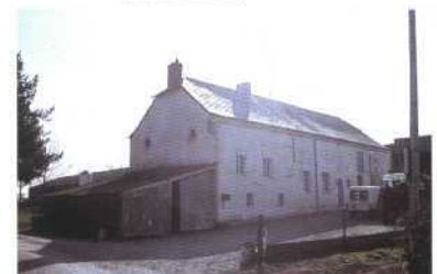
ferme à Beaufrepaire-sur-Sambre
