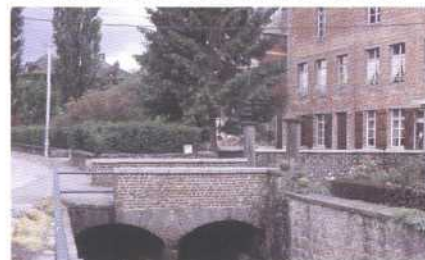
Etroeungt : les petits pont desservant les habitations
