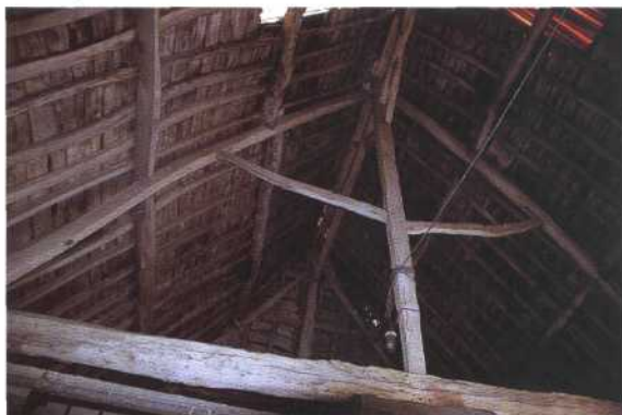
ferme : assemblage principal de la charpente
