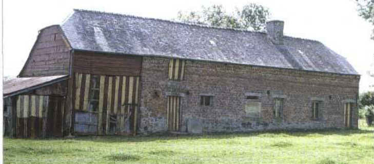
Ferme élémentaire à Beaufort-sur-Sambre
