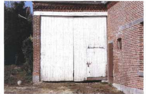
porte charretière d'une grange dite "en retour"
