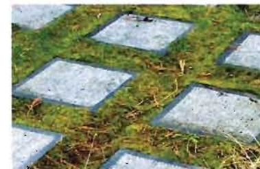
Dalle de béton en pas japonais
