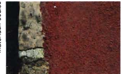
Enrobé rouge et bordure pavée
