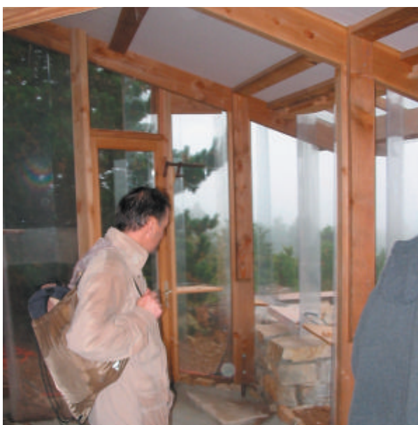
Façade en polycarbonate plié protégeant un espace tampon © CAUE 30
