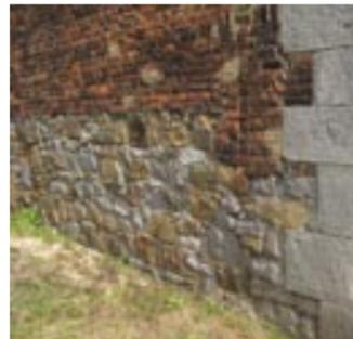
Sousbassement en moellons de grès et pierre bleue, mur en briques rouges et chaînage d'angle en pierres bleue taillées
