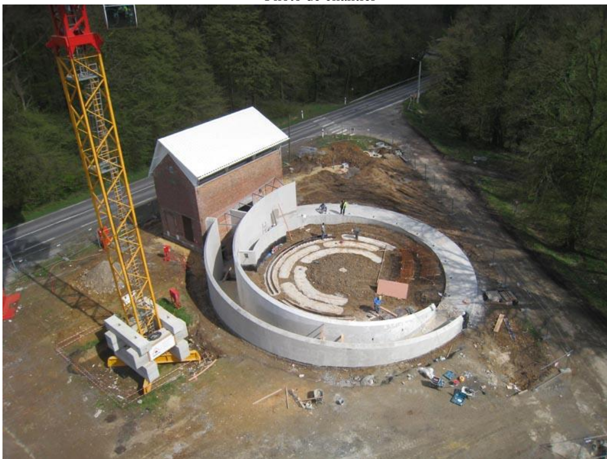
Photo de chantier
