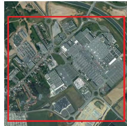
La STRUCTURE de la zone commerciale
