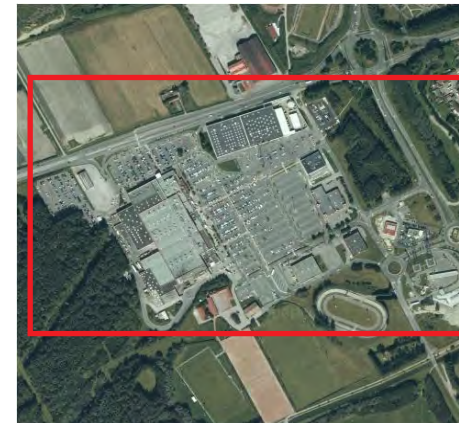
La STRUCTURE de la zone commerciale
