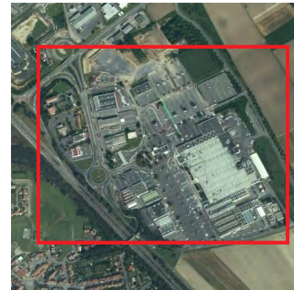
La STRUCTURE de la zone commerciale
