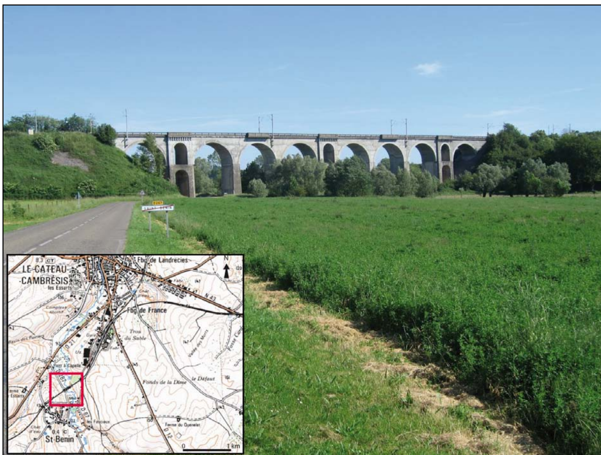
Photographie 10 : Le viaduc de St Benin (Réalisation : François Herbertte – Photographie : Alain Battermann)
