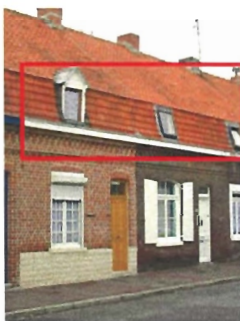
Modification des ouvertures en toiture :
