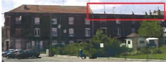
Rang de maisons dont la toiture deux pans a été remplacée pour partie par une toiture-terrasse. Conséquences : mise en place d'une rupture dans le rang et perte d'espace à l'intérieur du bâti (suppression des combles).
