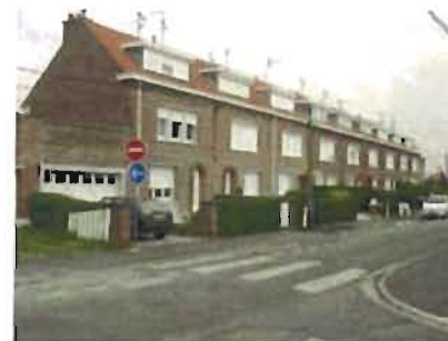
Avenue de la Pépinière
