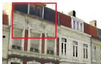
13-15 rue H. Barbusse : Rang de maisons dont les brisis des toitures sont couverts de tuiles. Celui de la maison de gauche a laissé place à l'ardoise.
