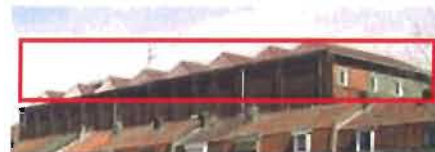
22 rue du Général Dame : Usine dont les matériaux traditionnels de la toiture en sheds ont été remplacés par la tôle.
