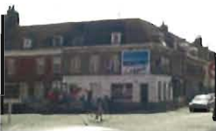
Angle rue Lhermitte / rue Vanderhaeghen
