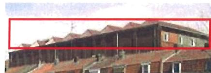
22 rue du Général Dame : Usine dont les matériaux traditionnels de la toiture en sheds ont été remplacés par la tôle.
