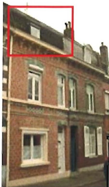
32-34 rue du Colonel Fabien : Ensemble de deux maisons dont le brisis de la toiture est à l'origine couvert en ardoises. La maison de gauche les a remplacés par un matériau de substitution (bardeaux d'asphalte, "shingles"). Conséquences : perte d'un élément d'unité des deux maisons et perte de la qualité de la couverture.
