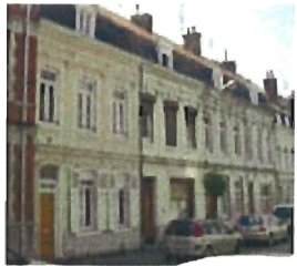
Rue du Gal Leclerc
