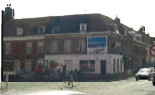
Angle rue Lhermitte / rue Vanderhaeghen
