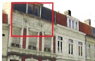
13-15 rue H. Barbusse : Rang de maisons dont les brisis des toitures sont couverts de tuiles. Celui de la maison de gauche a laissé place à l'ardoise.
