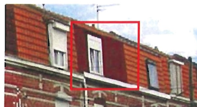
47-53 rue P. Doumer : Rang de maisons dont les brisis des toitures sont à l'origine couverts de tuiles. L'une d'elle l'a remplacé par un matériau de substitution (bardeaux d'asphalte, "shingles").
