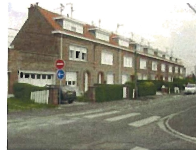
Avenue de la Pépinière
