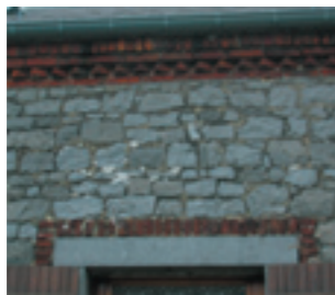
La brique sur le linteau et sous le chéneau
