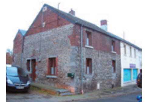
Ancienne maison de pierre rehaussée en brique, divisée et partiellement enduite.
