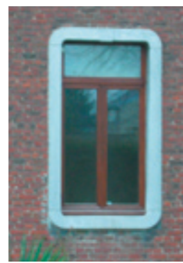
Encadrement de pierre bleue avec forme arrondie aux angles
