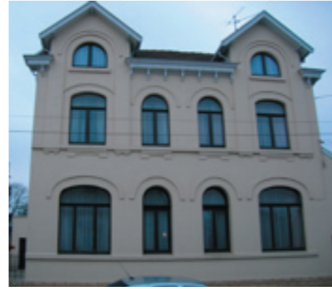
Façade brique, enduit ciment et peinture
