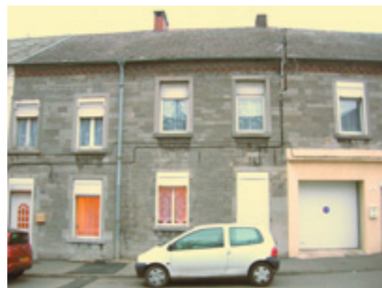
Maçonnerie en bloc de pierre bleue taillée
