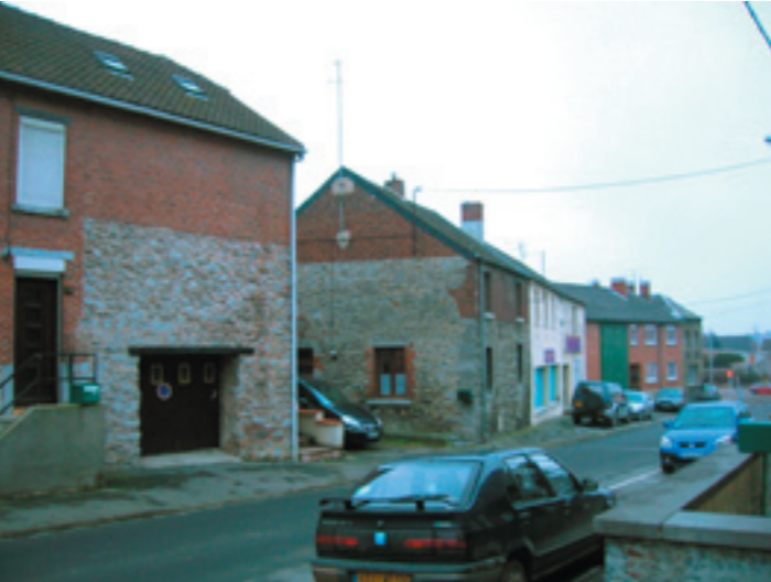
4 - En bas de la rue Roger Salengro : L'habitat ancien du noyau contraste avec l'alignement des pavillons du XIXème, au sud.
