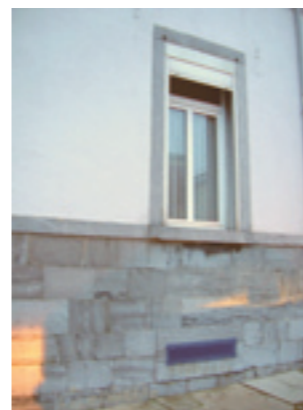
Sous-bassement et encadrement de pierre bleue avec façade enduite
