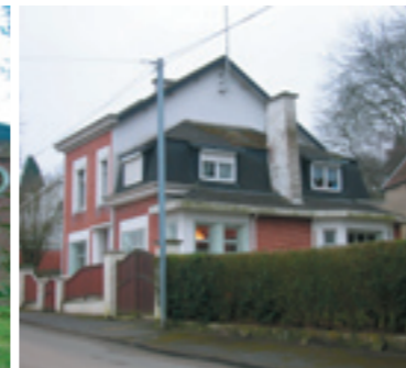
Maisons mitoyennes adossées pour ouvrir sur un jardin allongé.
