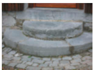
Emmarchement circulaire en pierre bleue
