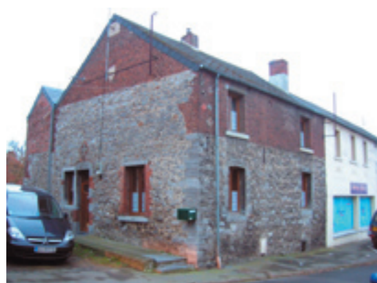
Murs en moellons de pierre avec rehaussé de briques
