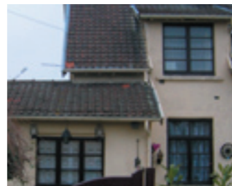
Les châssis bois d'origine
