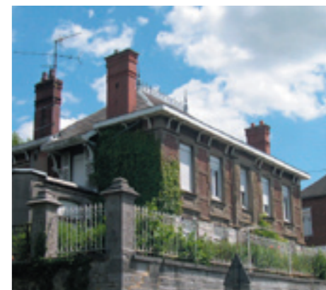
Maçonnerie en opus incertum avec marquage des joints en saillie.
