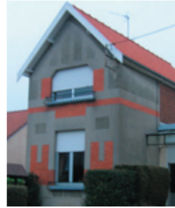
Enduit ciment et brique, façon art-déco.
