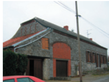
Ancien corps de ferme apprentis et porche, transformé en habitation
