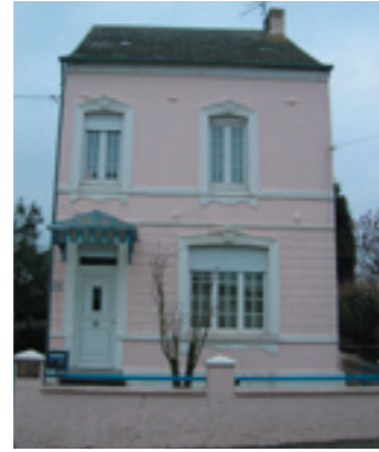
Façade brique, enduit et peinture
