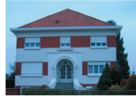
Façade béton et brique
