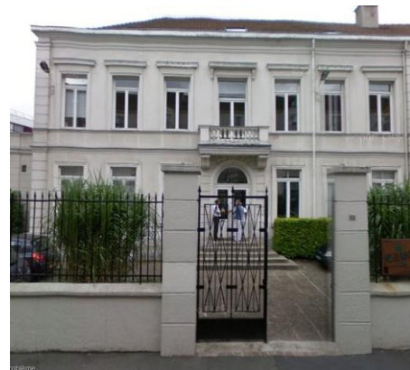
Photo 1 : Etablissement du CAUE du Nord situé à Lille
