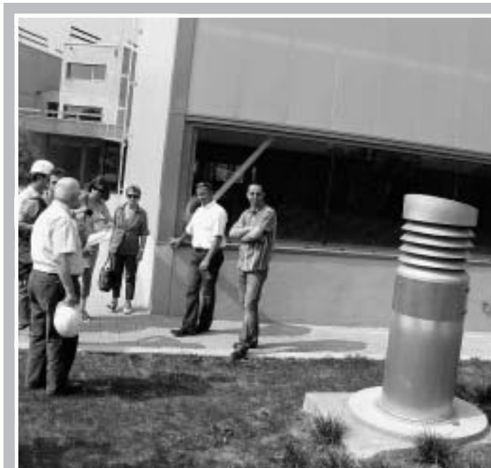
Le fameux puits canadien permet de profiter de la température constante du sol et de réaliser de substantielles économies d'énergie. La salle de sports ouvrira ses portes à la rentrée : il ne reste plus que le revêtement de sol à poser.
