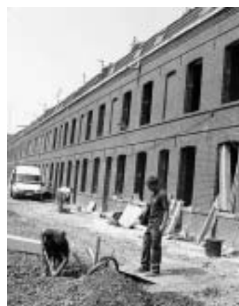
Cour Rémy, rue de Lannoy, les travaux ont démarré.
